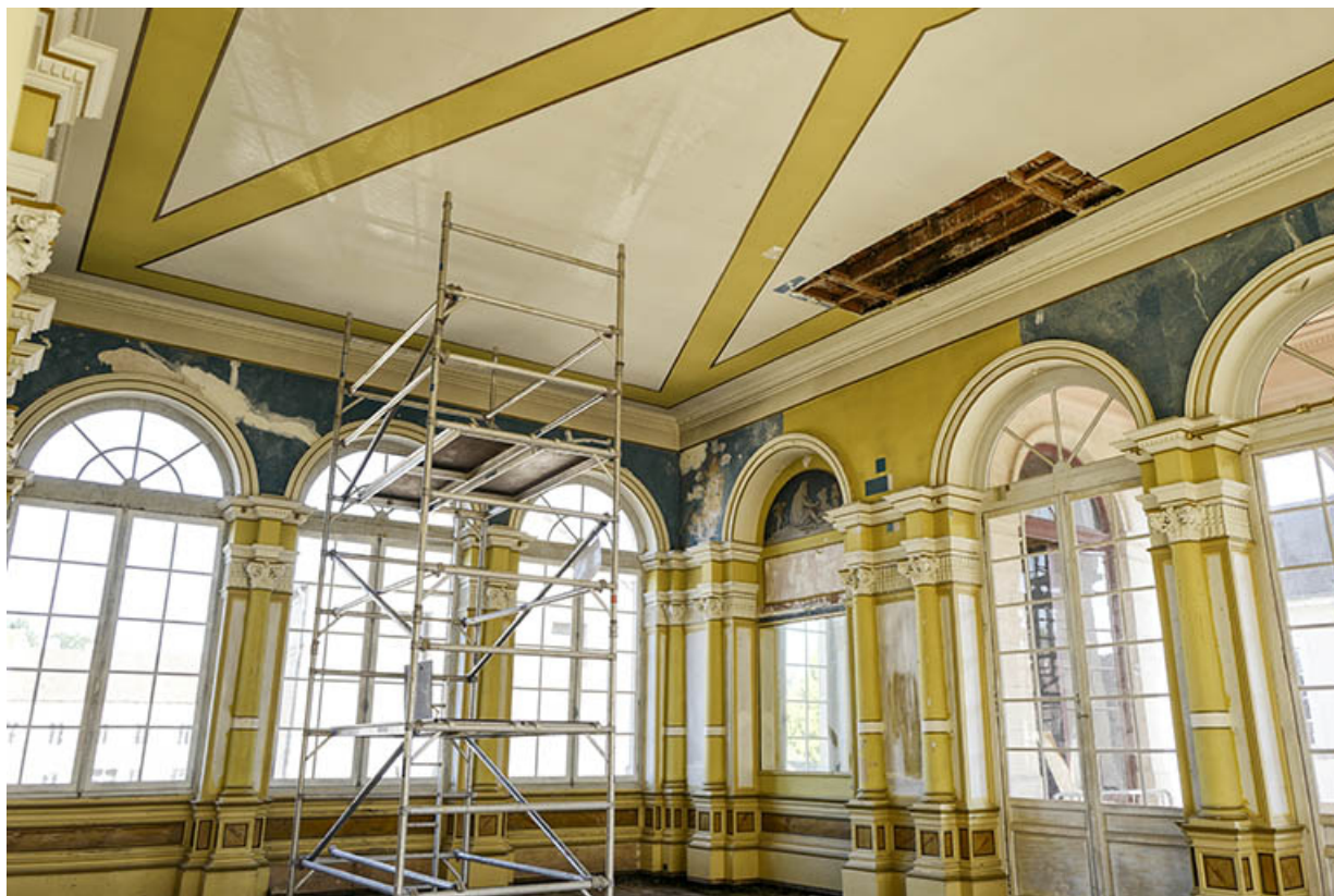
Foyer en cours de restauration, en 2020.
