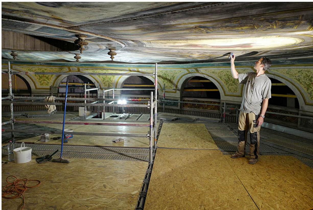
Plafond de la salle en cours de restauration, en 2020.
