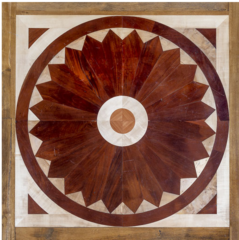
Foyer : rosace au parquet.
