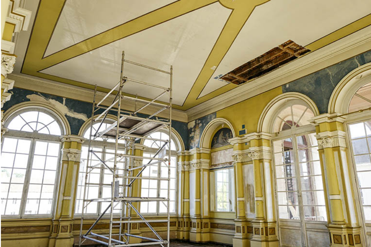
Foyer en cours de restauration, en 2020.
