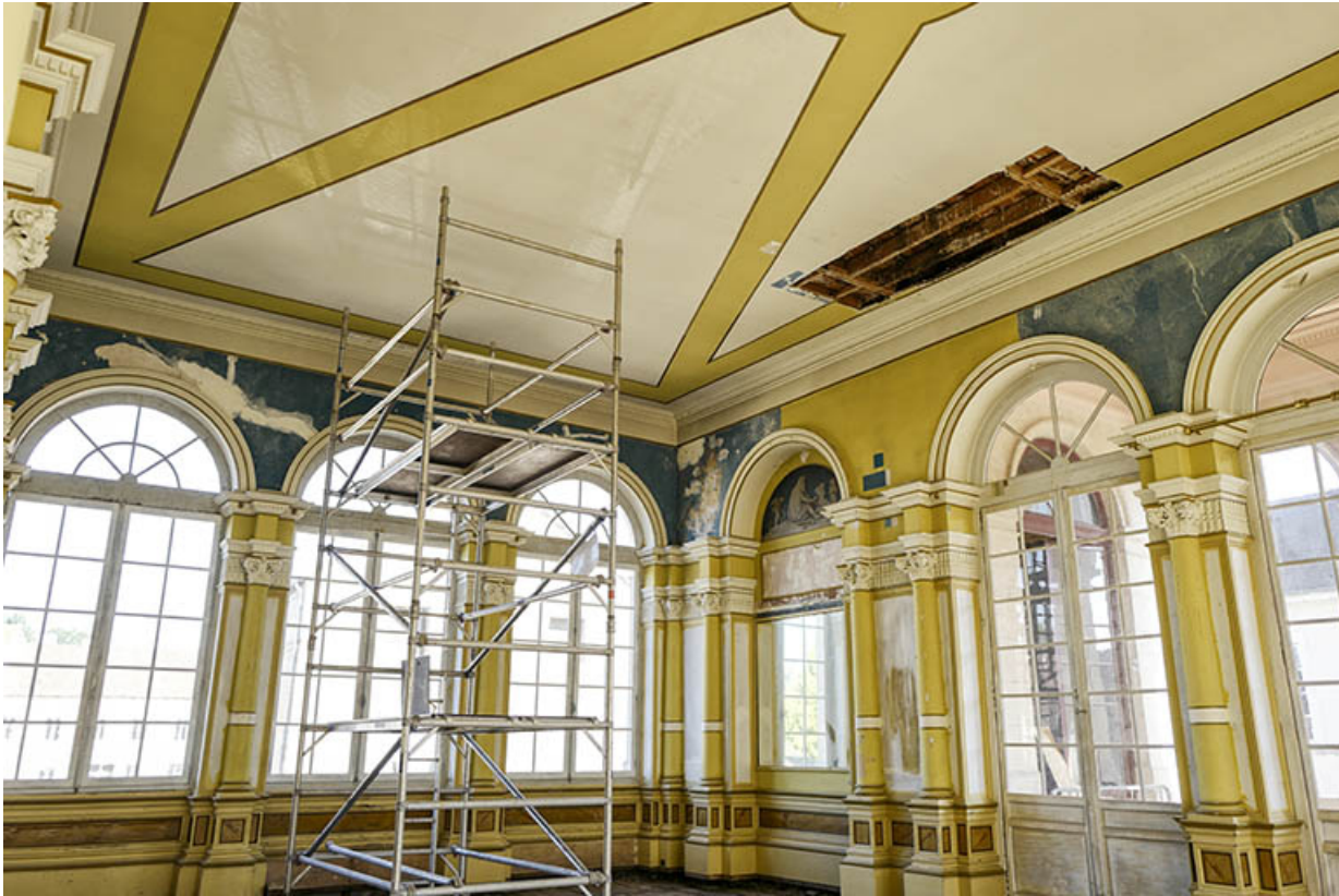
Foyer en cours de restauration, en 2020.
