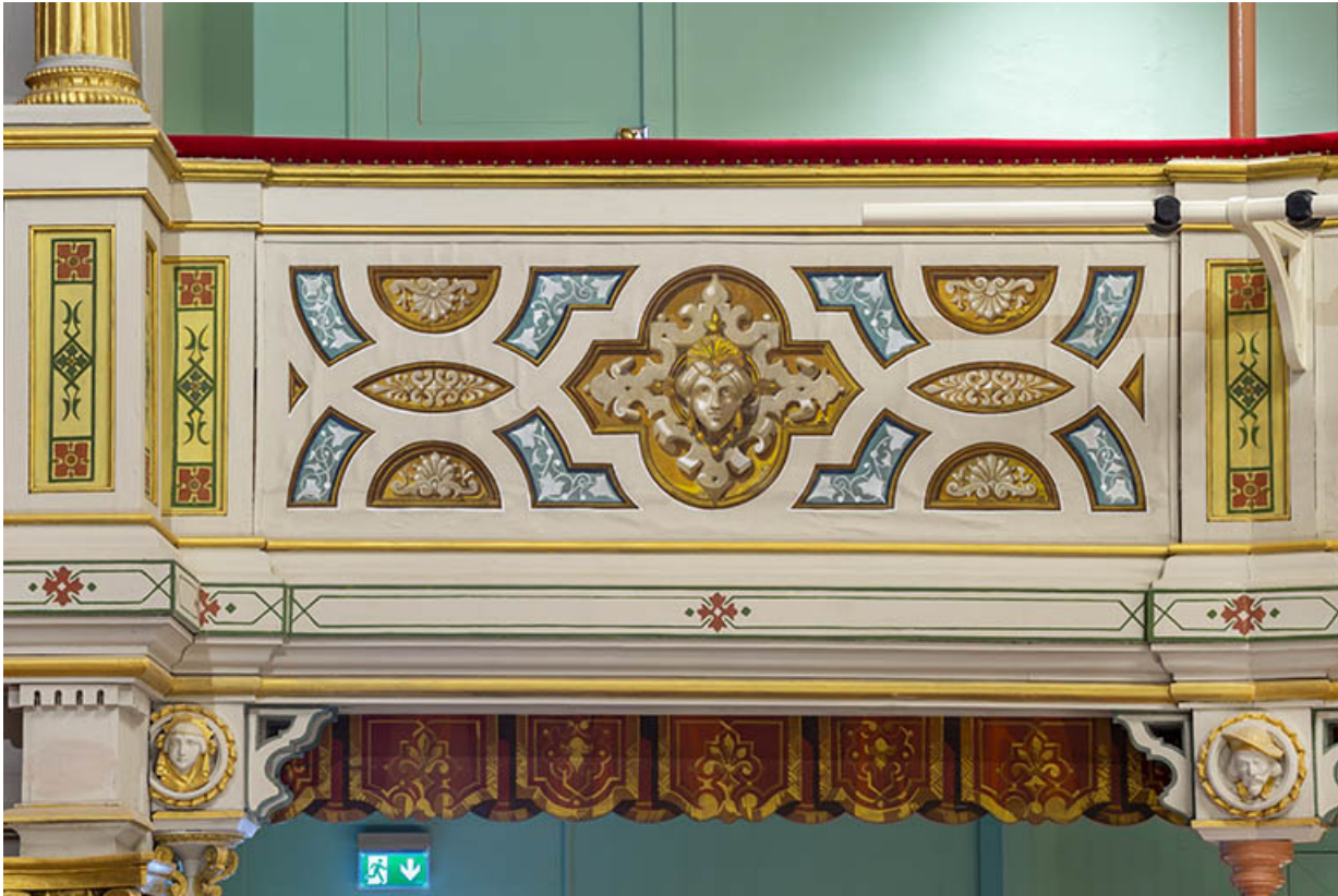
Salle : décor du garde-corps du 2e balcon, près de la loge d'avant-scène côté cour. 39, Dole, 30 rue du Mont-Roland
