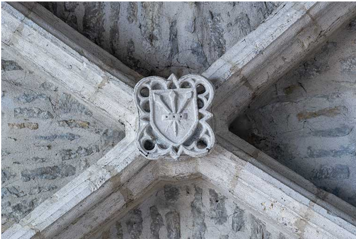
Clef de voûte de la chapelle, écu portant trois clous appointés. 39, Poligny rue du Collège
