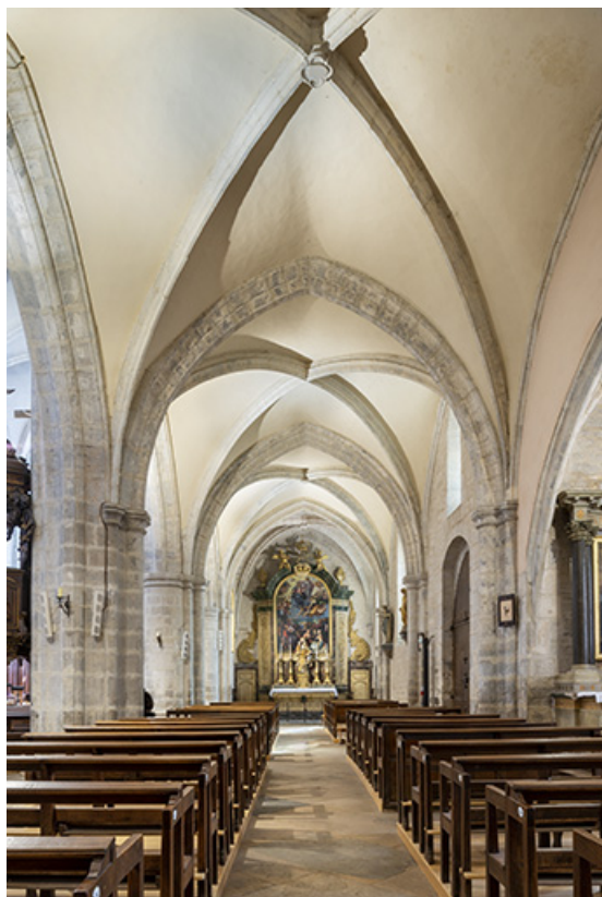
Situation de la chapelle du fondateur, à l'extrémité du bas-côté sud. 39, Poligny rue du Collège
