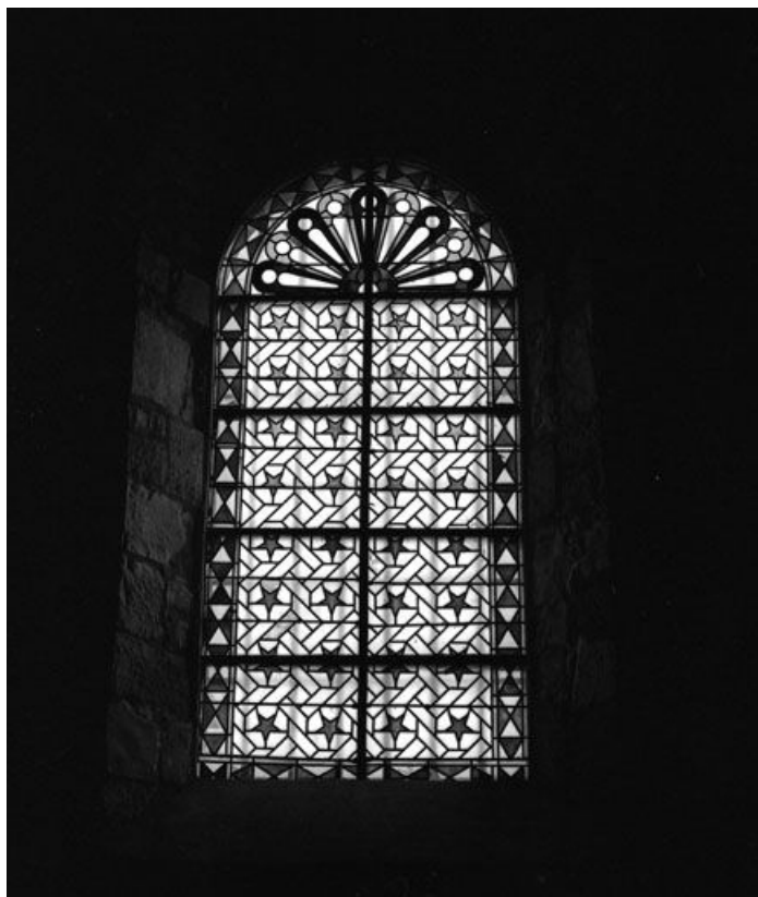
Baie 5 : vue d'ensemble.
