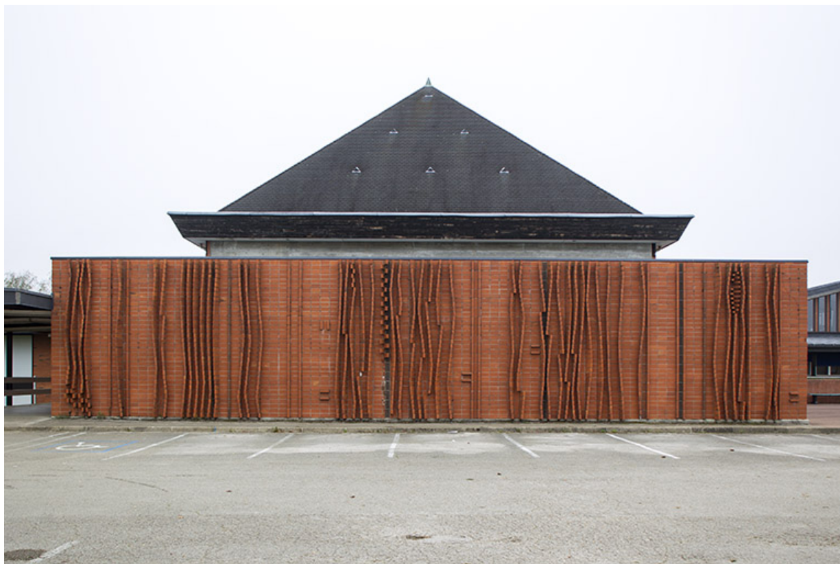
Vue de face du long mur sud.
