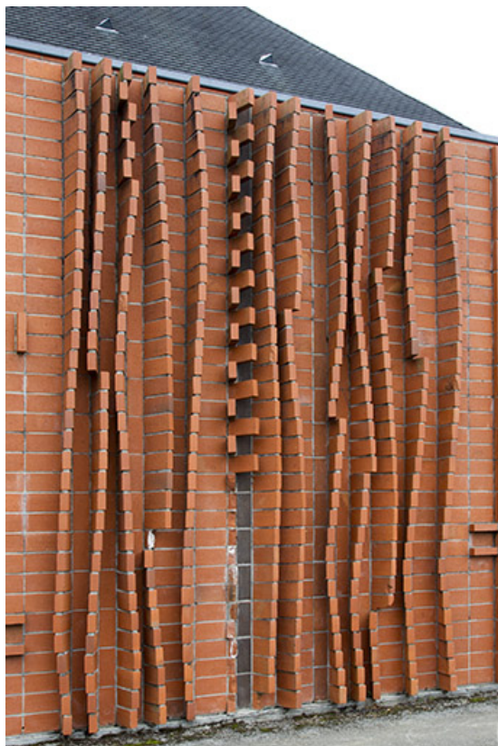
Détail du mur sud. Vue de trois-quart.
