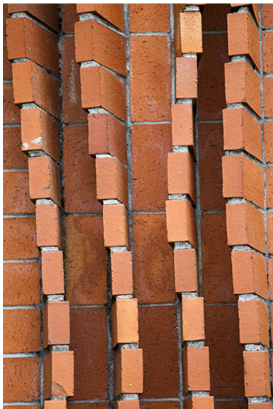
Détail du mur sud. Vue rapprochée.
