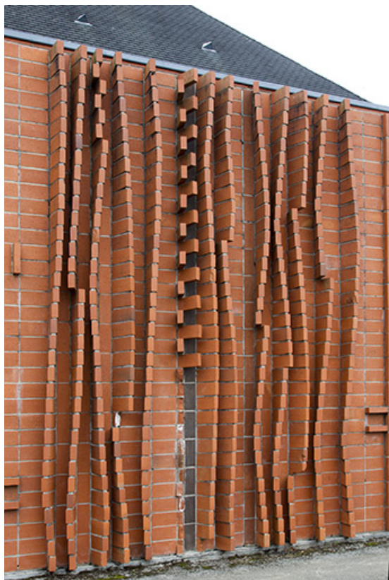
Détail du mur sud. Vue de trois-quart.
