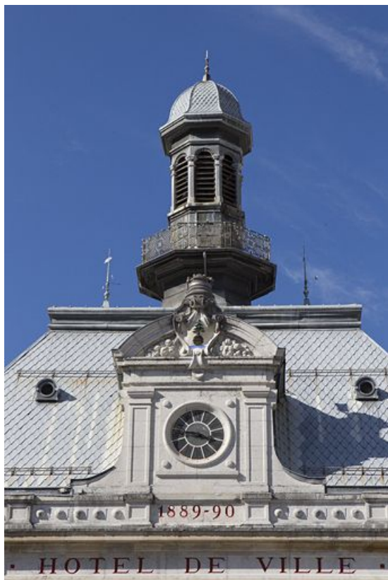
Le cadran, intégré au fronton du pavillon central.
