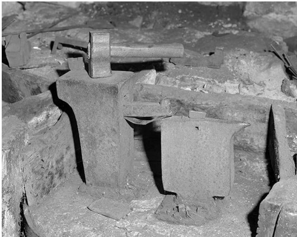
Poste de travail équipé avec la matrice pour les clous.
