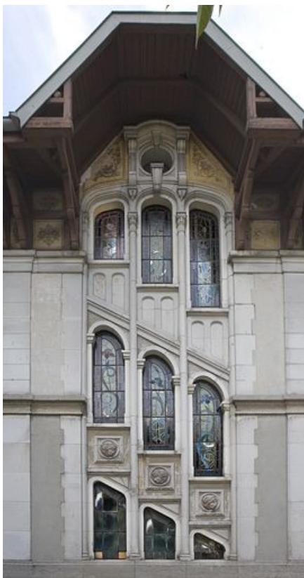
Vue d'ensemble, depuis l'extérieur.
