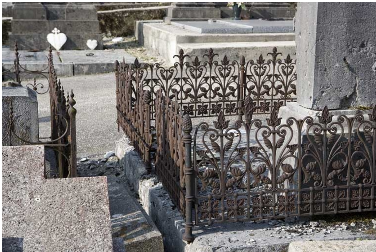
Vue d'ensemble : faces postérieure et latérale droite.
