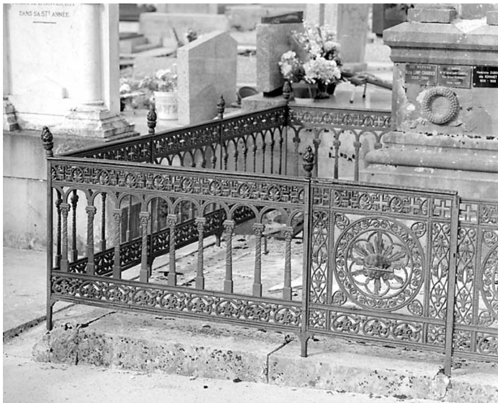
Élévation antérieure : grille fixe et vantail du portillon.
