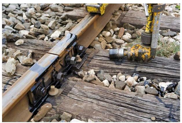
Tête de serrage. La machine est utilisée pour resserrer des boulons d'éclisses.
