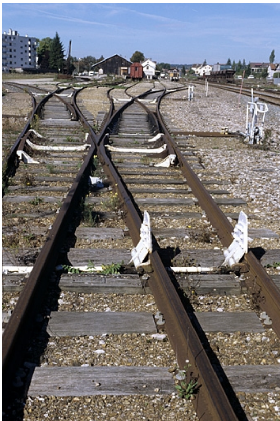
Vue d'ensemble des voies de service ouest, avec les taquets d'arrêt au premier plan.
