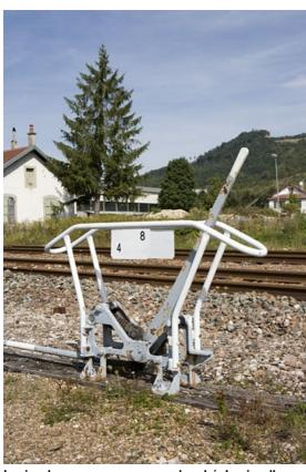
Levier de manoeuvre non enclenché. Levier d'appareil de voie des voies 4 et 8, à l'ouest, à l'extrémité de la gare côté La Cluse. 39, Champagnole, 13 avenue de la Gare
