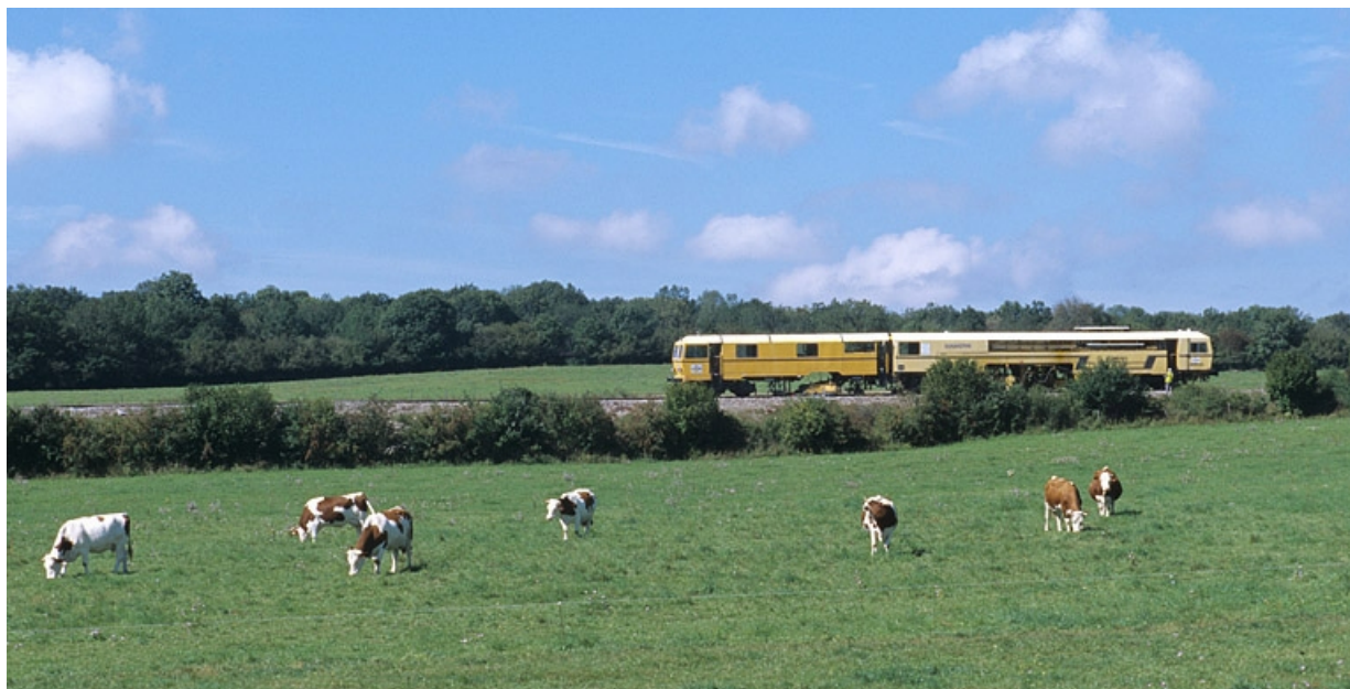
La voie entre Andelot-en-Montagne et Champagnole. Train de meulage, sur la commune du Pasquier.
