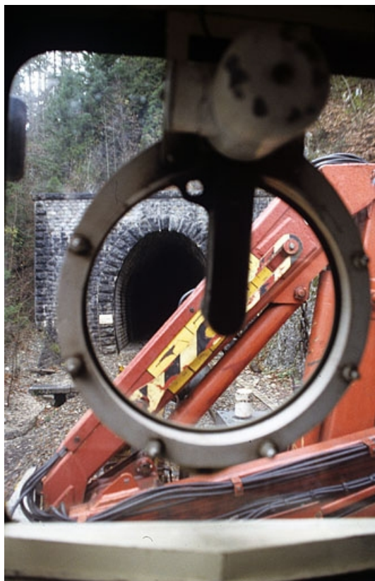
Hublot. Approche de la tête du tunnel de la Joux côté Andelot-en-Montagne (vers le PK 039.020). 39, Morez, 15, 17 avenue Charles de Gaulle
