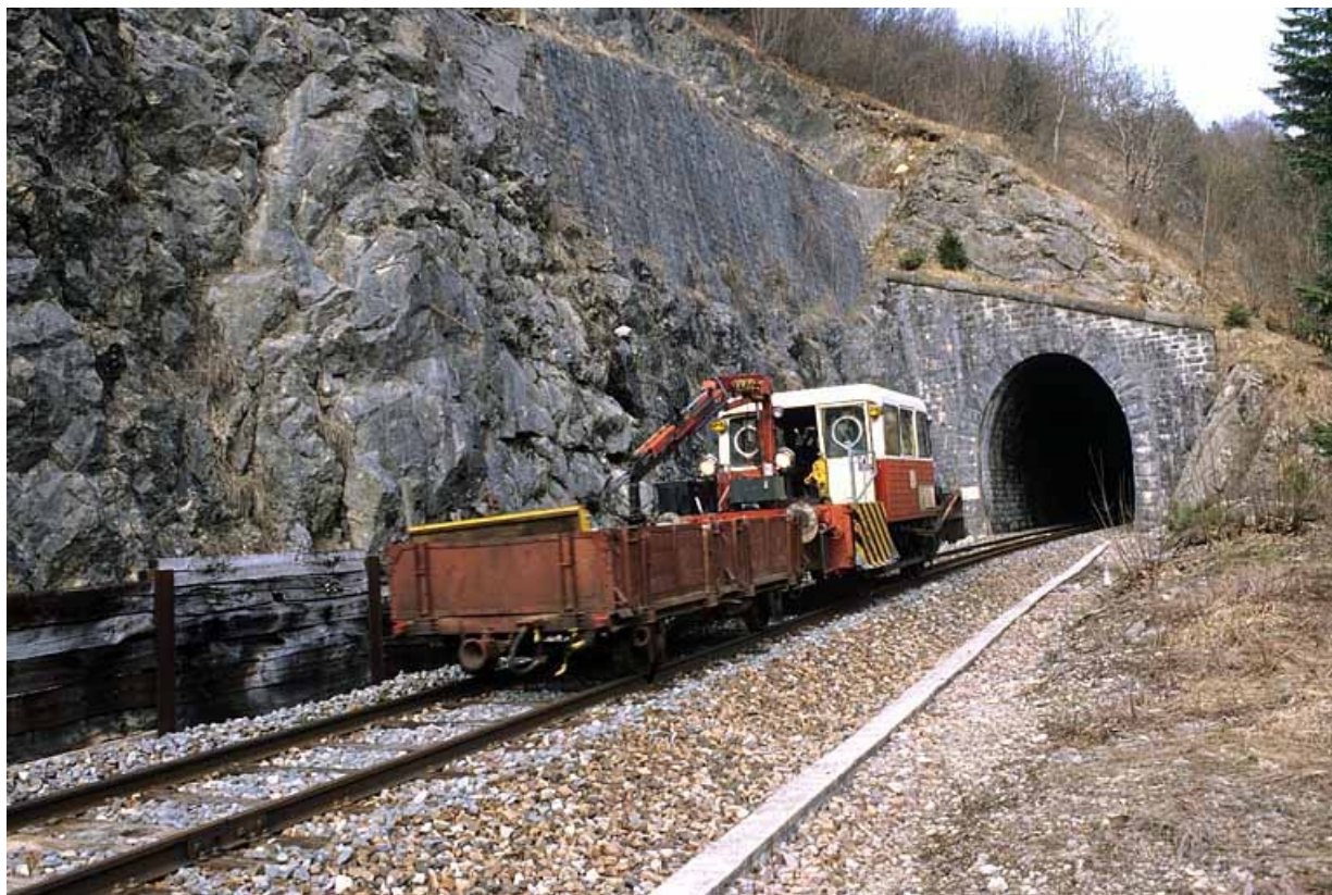
Draisine sortant du tunnel du Pâturage (tête côté La Cluse).
