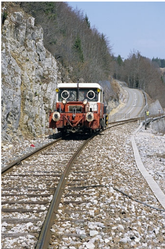
Vue d'ensemble de face. Chantier d'entretien de la voie à l'extrémité du viaduc des Crottes côté La Cluse (vers le PK 045.200). 39, Morez, 15, 17 avenue Charles de Gaulle
