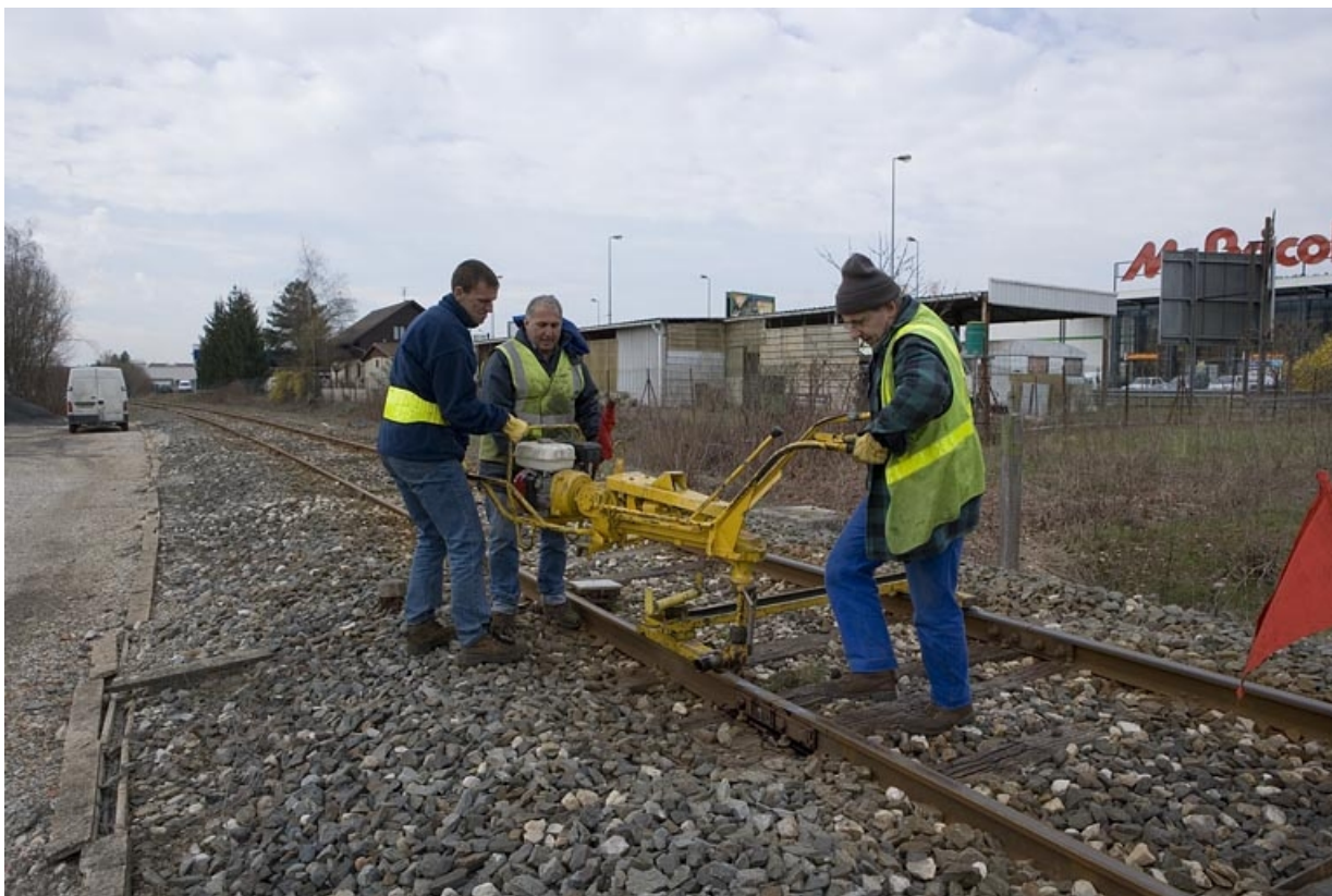
Mise en place par les agents de l'Équipement. Les agents placent le corps de la tirefonneuse sur son bâti, positionné sur les rails. in, Jura
