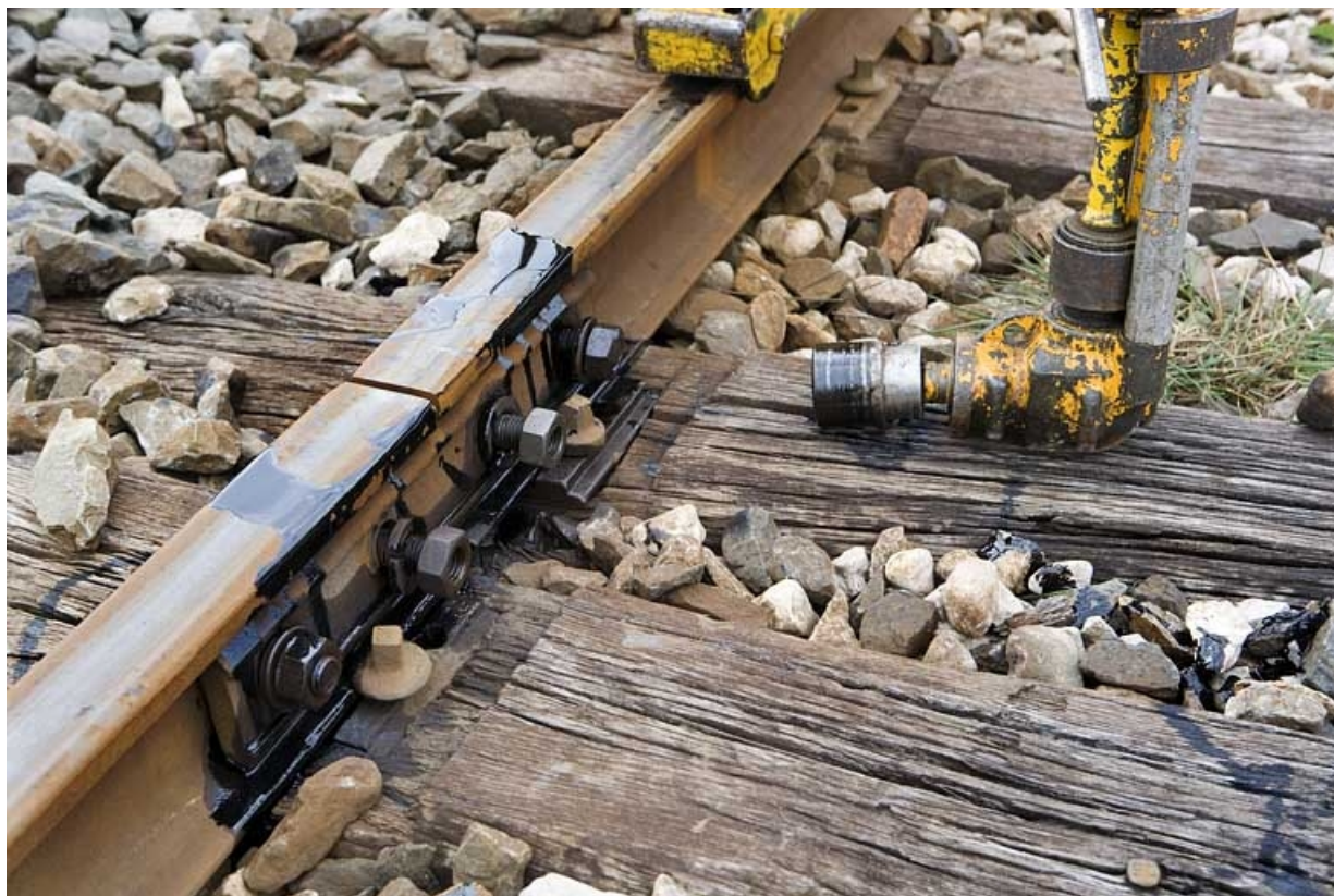
Tête de serrage. La machine est utilisée pour resserrer des boulons d'éclisses. in, Jura
