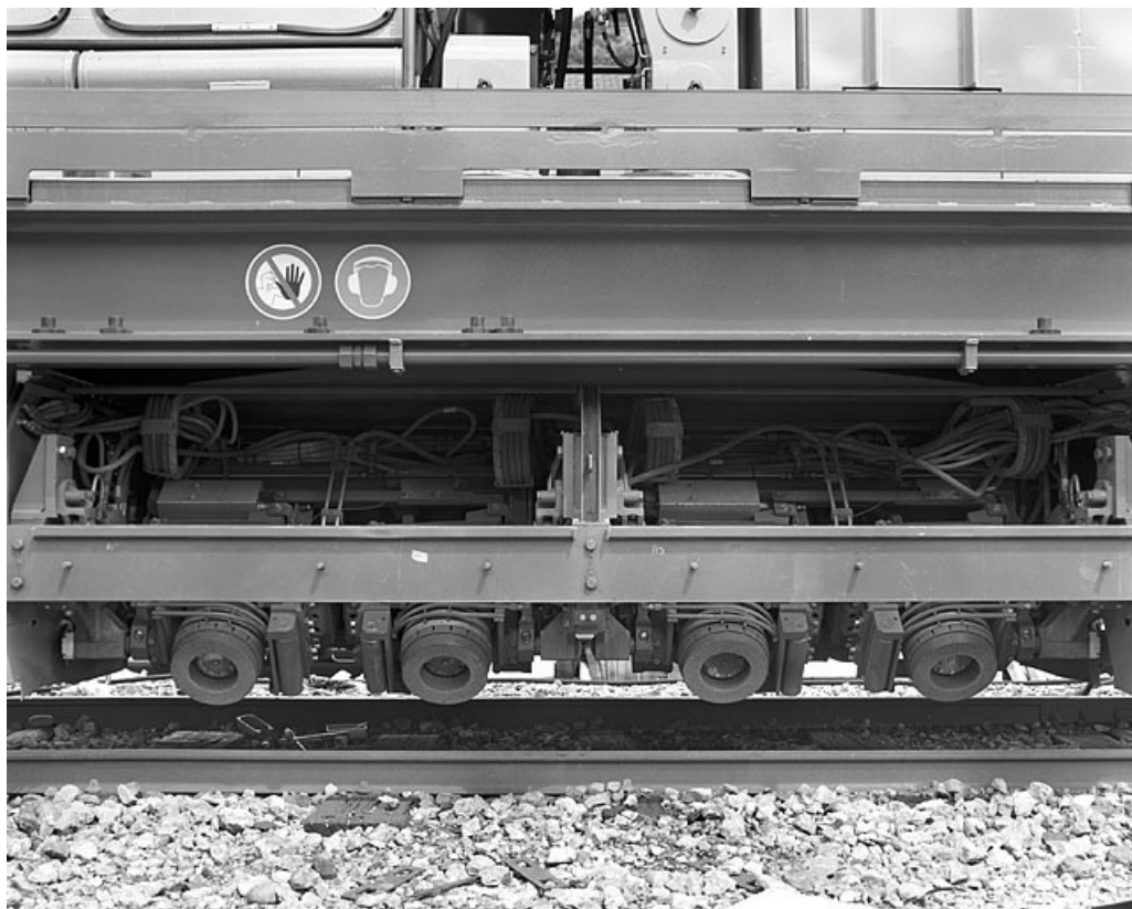
Train de meulage : système de meulage. in, Jura
