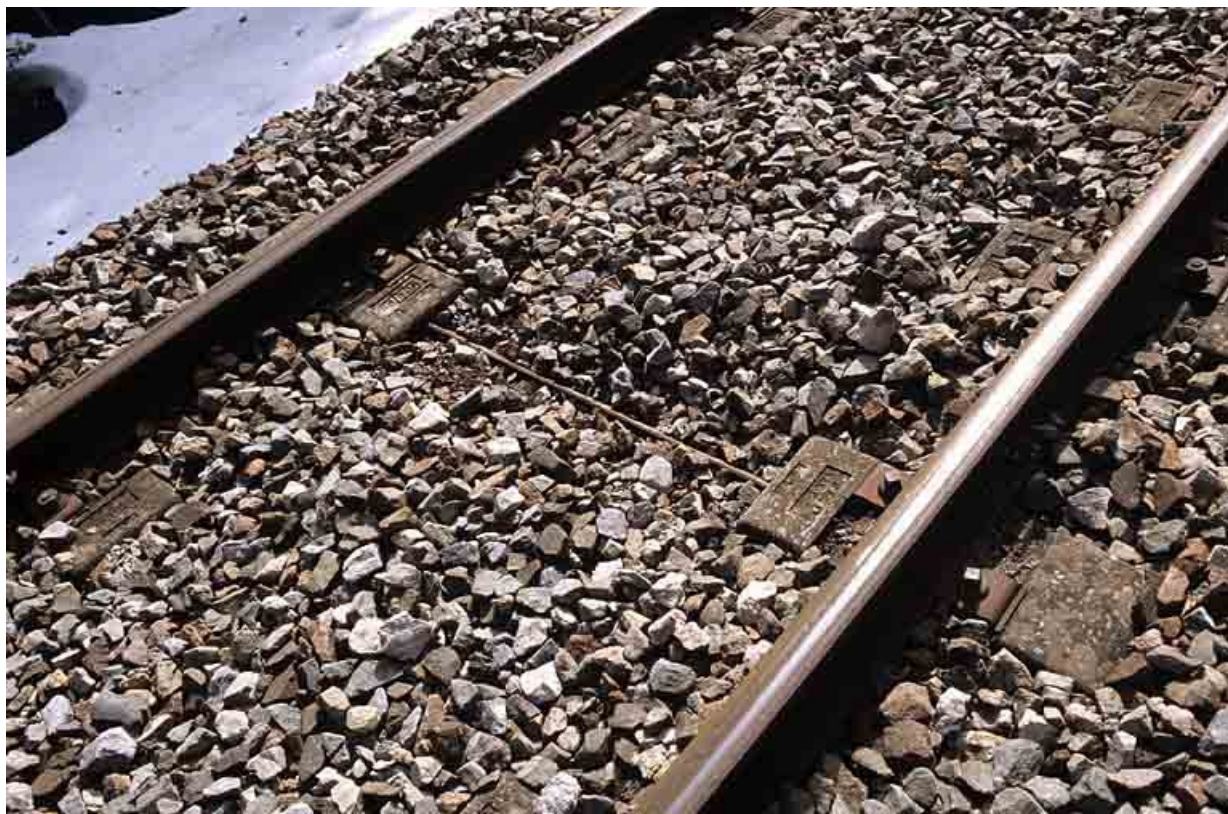
Vue plongeante sur une traverse Sateba, à proximité du pont sur la R.D. 18 (PK 045.208), commune de Morbier. in, Jura
