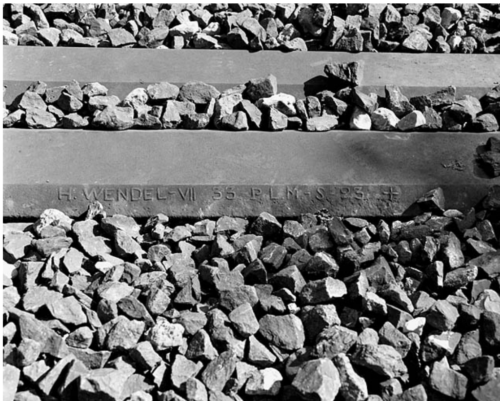
Inscription sur une traverse double : H. Wendel. Cette traverse est en place près du point kilométrique 100.200, peu avant le souterrain d'Arbent 1 (commune d'Arbent, Ain). in, Jura
