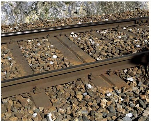
Traverses simples et doubles. Ces traverses sont en place près du point kilométrique 100.200, peu avant le souterrain d'Arbent 1 (commune d'Arbent, Ain).
