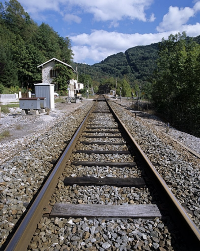
Exemple de voie avec traverses en bois. Voie ferrée au point kilométrique 070.700, en aval du passage à niveau n° 54 (commune de Saint-Claude).
