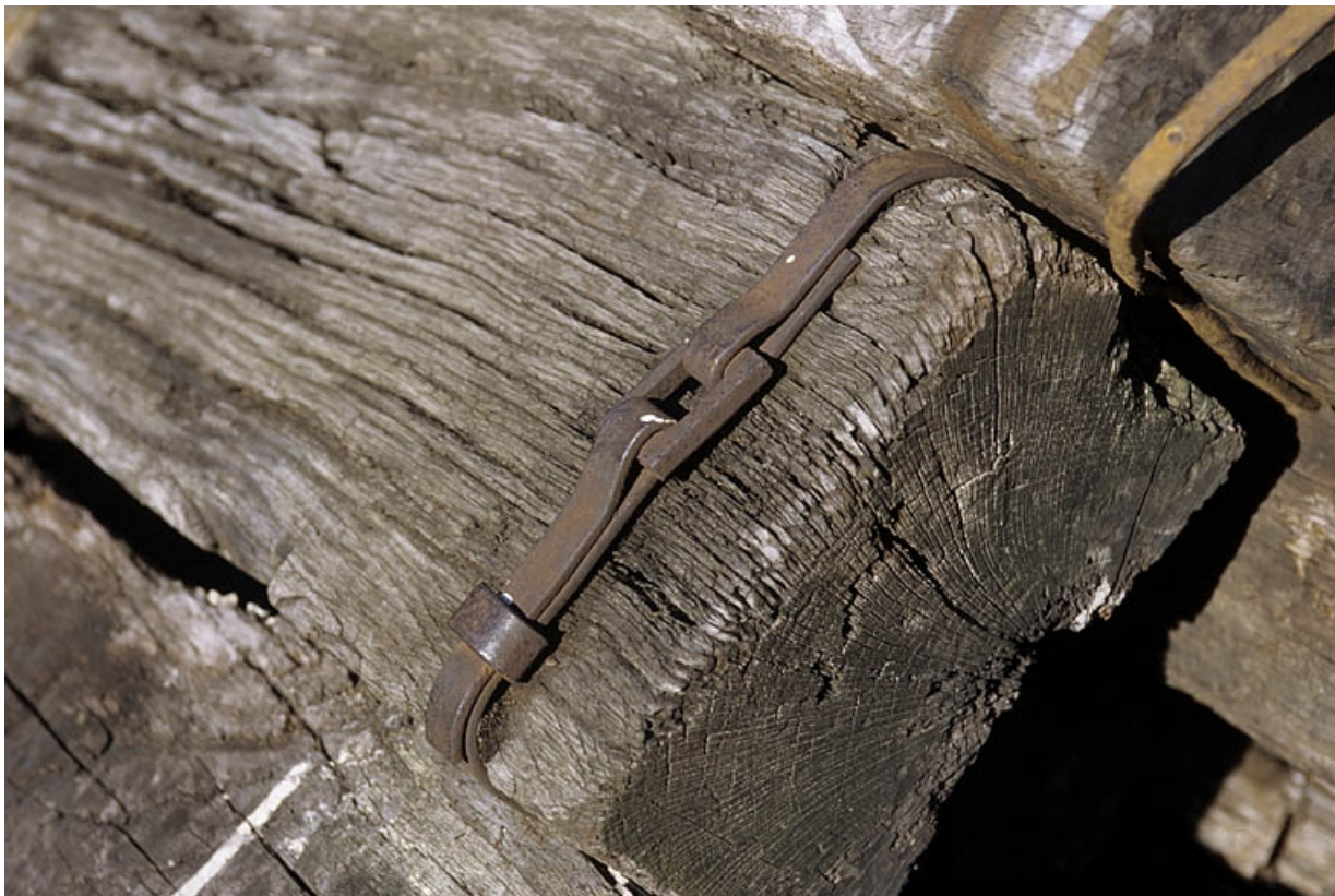
Extrémité d'une traverse avec frettage Delor. in, Jura
