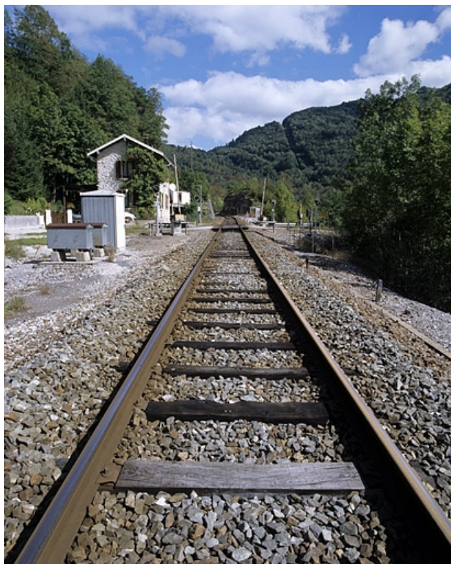
Exemple de voie avec traverses en bois. Voie ferrée au point kilométrique 070.700, en aval du passage à niveau n° 54 (commune de Saint-Claude).
