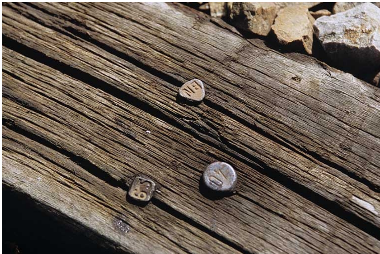
Traverse avec clous. Traverse fabriquée en 1965 (clou à tête carrée avec le millésime 65) par l'atelier Arnaud Beaunartin (Neuf-Brisach, Haut-Rhin) et destinée à être posée avec un écartement de 1,440 m (clou à tête ronde portant le nombre 40). in, Jura
