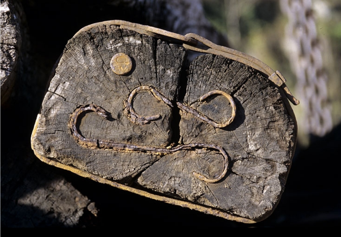
Extrémité d'une traverse avec frettage Delor, essences et clou. in, Jura
