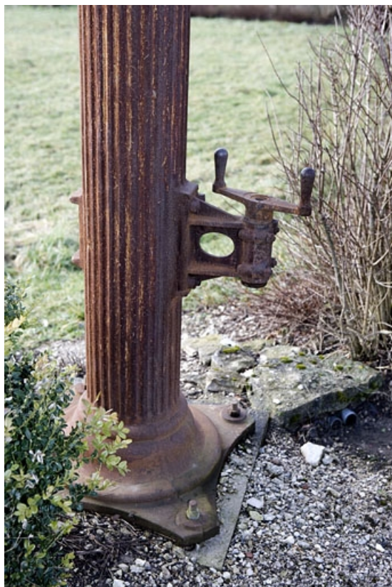
Manivelle à la base du fût.
