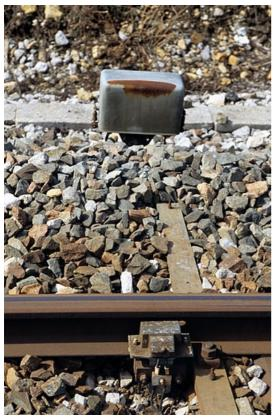
Pédale électronique : vue d'ensemble. Cette pédale commande le contrôle de zone d'un passage à niveau.
