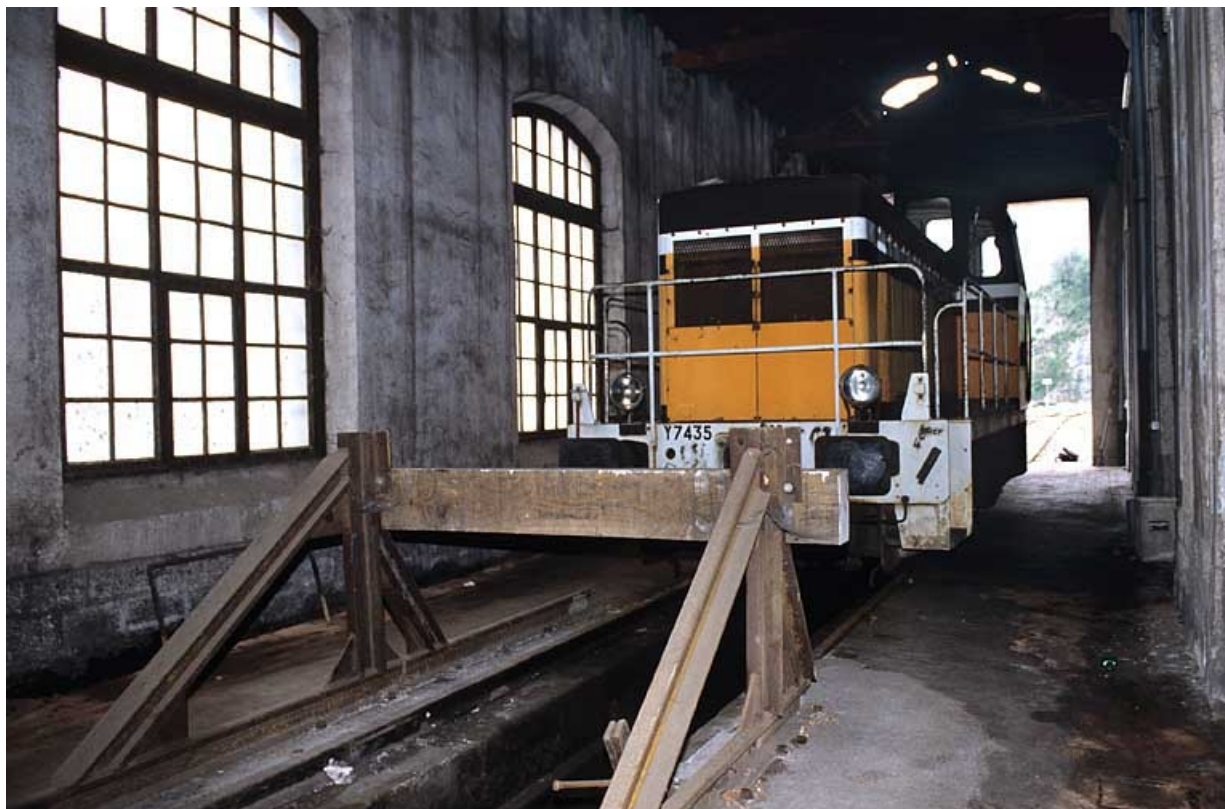
Exemple de butoir dans la remise ferroviaire (halle est). 39, Saint-Claude place de la Gare
