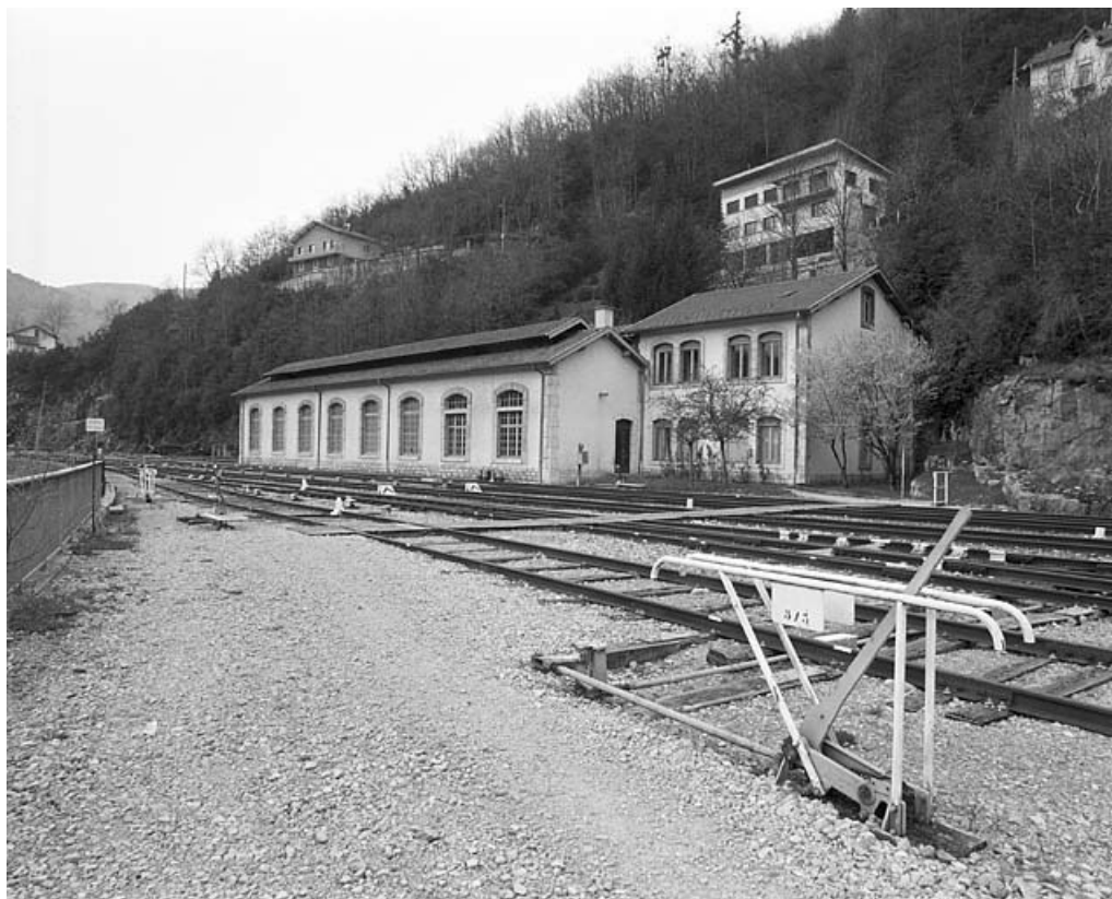
Au premier plan, sur le levier de manoeuvre non enclenché, la plaque donne le numéro des voies desservies par l'appareil. 39, Saint-Claude place de la Gare
