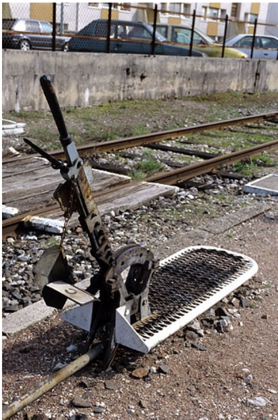
Levier de manoeuvre enclenché de l'appareil de voie C, à la jonction des voies 1 (A) et 11. La voie 11 est une voie de garage en cul-de-sac.
