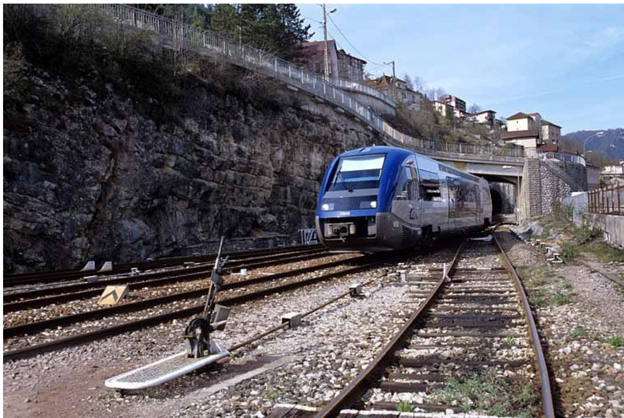
Garage d'un autorail X 73500 sur la voie 11 : refoulement sur la voie 1 (A). 39, Saint-Claude place de la Gare
