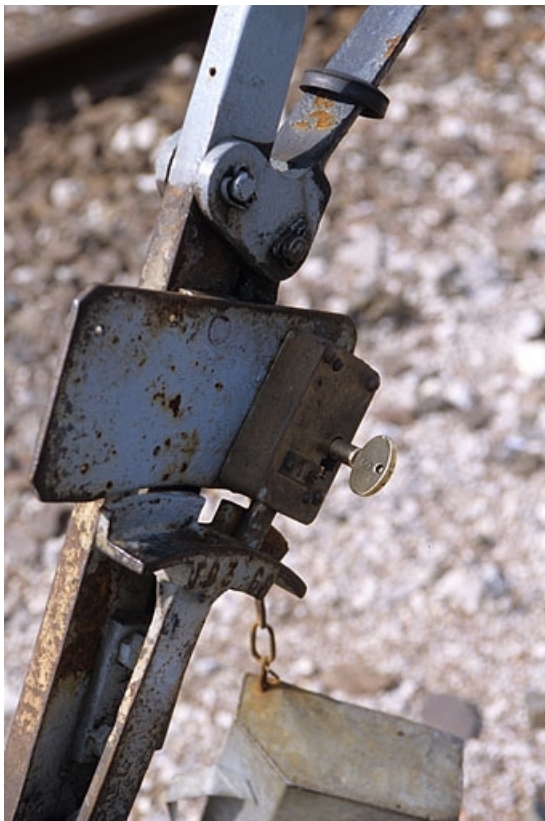
Levier de manoeuvre enclenché de l'appareil de voie C : détail de la serrure et de sa clef. 39, Saint-Claude place de la Gare
