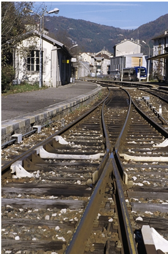
Appareil de la voie 2 (B), depuis la pointe de coeur au sud (côté La Cluse). 39, Saint-Claude place de la Gare
