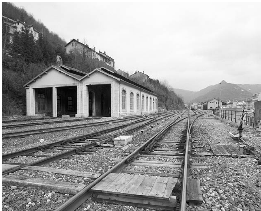
Faisceau des voies vers la remise ferroviaire, depuis le côté La Cluse. L'extrémité des aiguilles est visible pour les deux voies. 39, Saint-Claude place de la Gare
