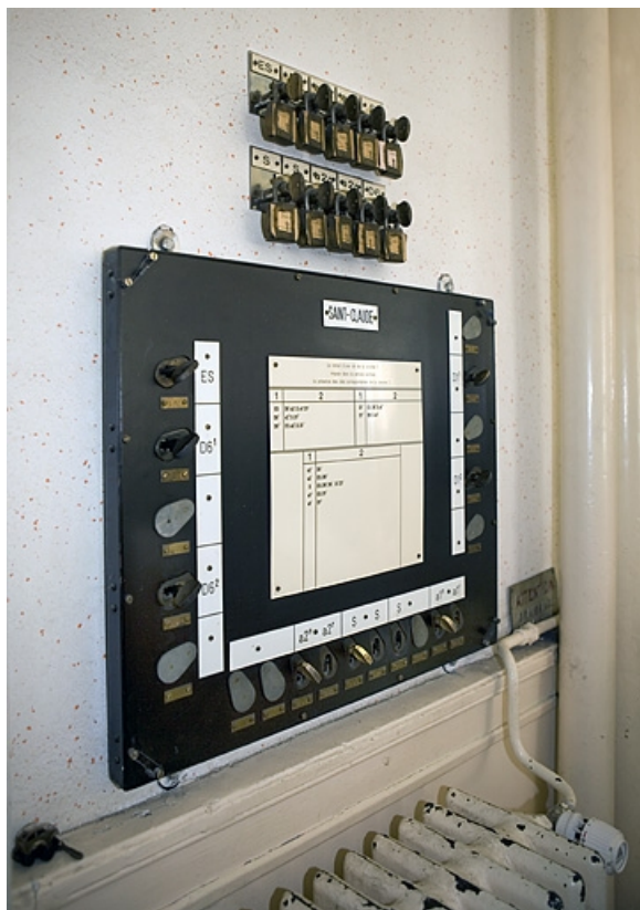
Vue d'ensemble, de trois quarts gauche. Cadenas et clefs de secours sont stockés au-dessus de la serrure centrale. 39, Saint-Claude place de la Gare
