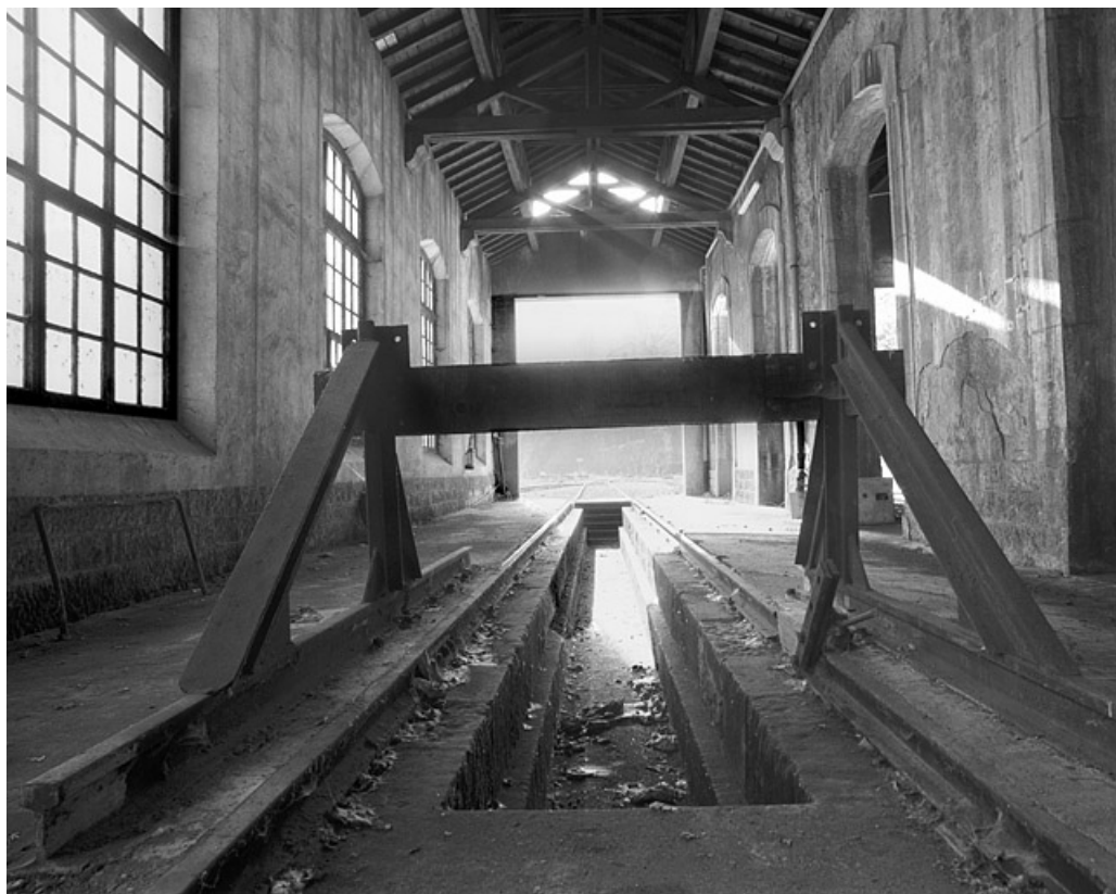
Remise ferroviaire : heurtoir et fosse à l'intérieur de la halle est.
