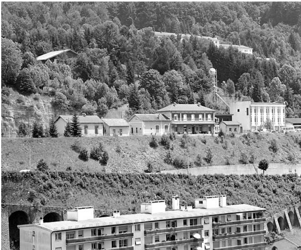
Vue d'ensemble de la gare, depuis le nord-ouest.
