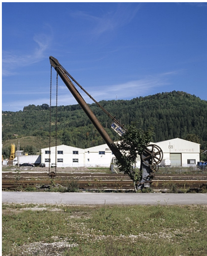
Vue d'ensemble de profil, depuis le sud-ouest.
