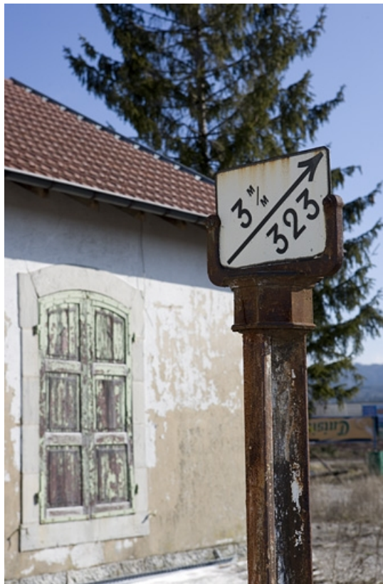
Face côté Andelot-en-Montagne. Le panneau signale que la voie est en rampe (pente ascendante) de 3 mm / m sur 323 m. 39, Champagnole, 13 avenue de la Gare
