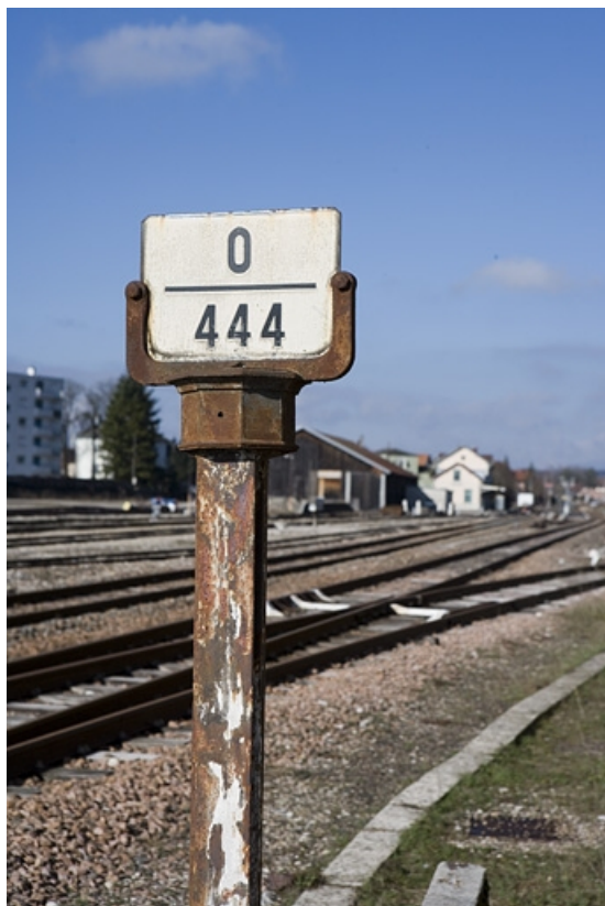
Face côté La Cluse. Le panneau signale que la voie est en palier sur 444 m. 39, Champagnole, 13 avenue de la Gare
