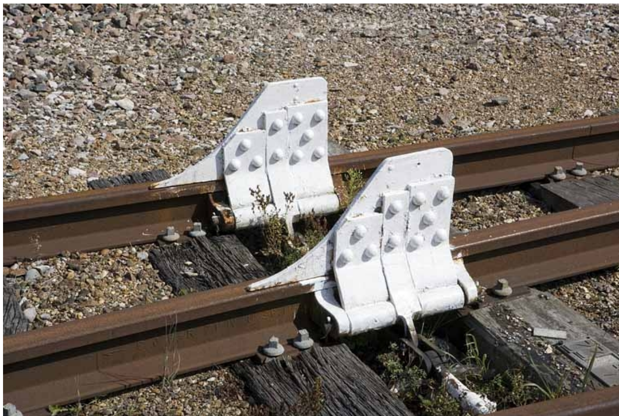
Les deux taquets, en position haute.
