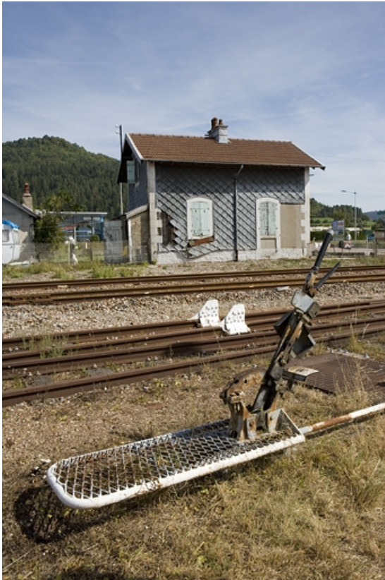
Vue d'ensemble du levier de manoeuvre et des taquets d'arrêt (peints en blanc).
