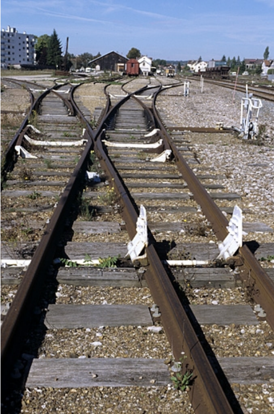
Vue d'ensemble des voies de service ouest, avec les taquets d'arrêt au premier plan. 39, Champagnole, 13 avenue de la Gare
