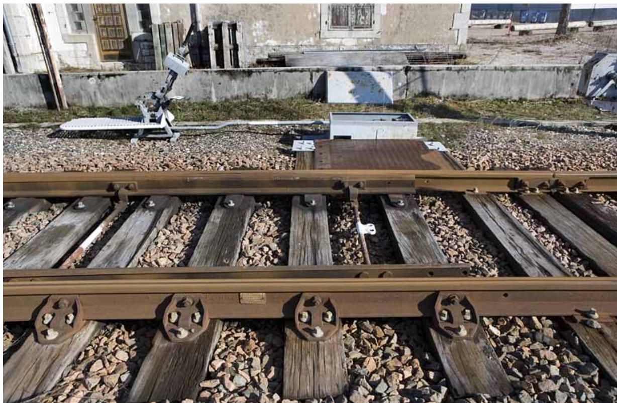
Levier de manoeuvre, système de renvoi d'angle et aiguilles.
