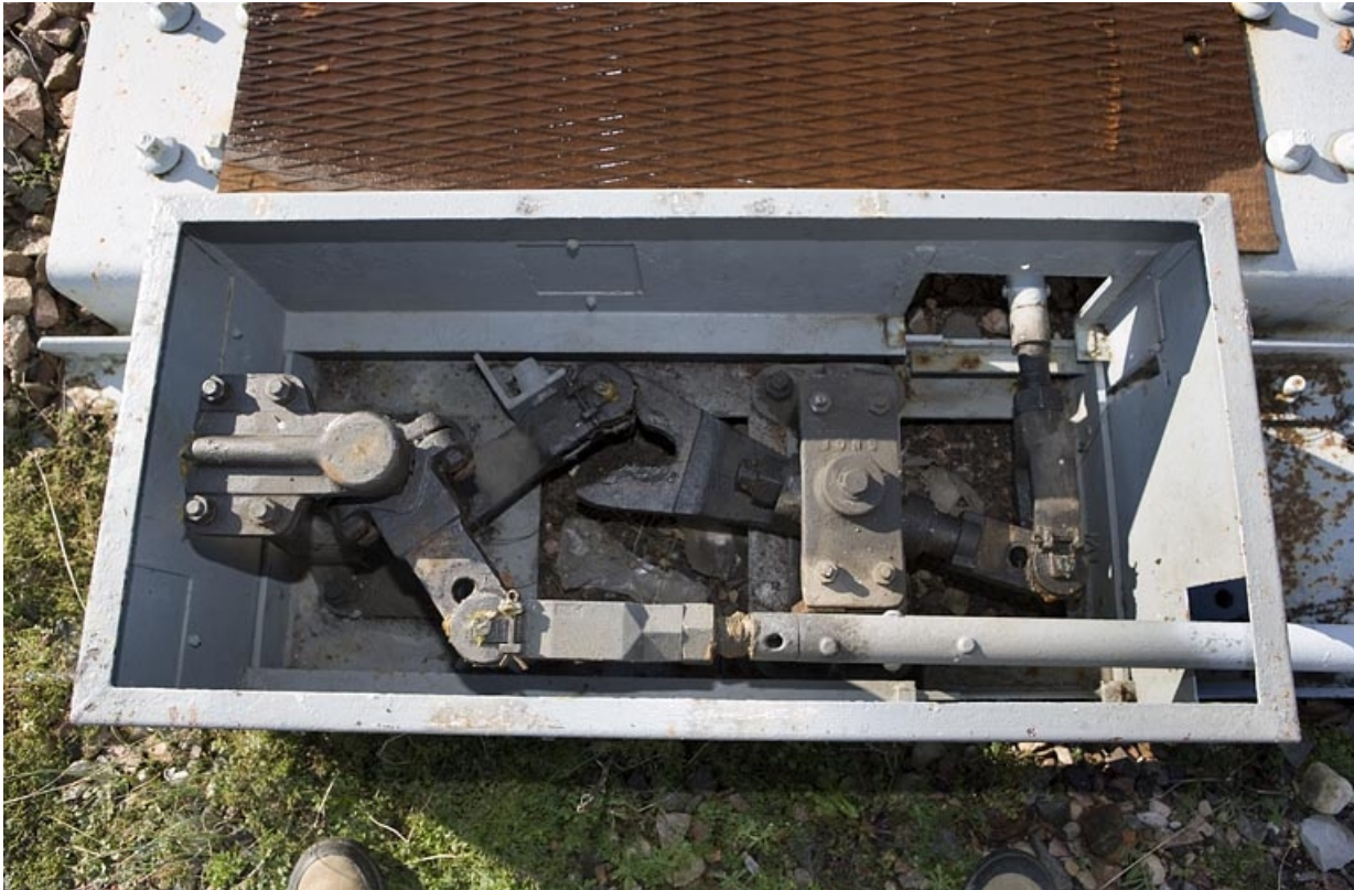
Système de renvoi d'angle. La tringle actionnant les aiguilles (en haut) est reliée à celle du levier de manoeuvre par une pièce métallique dite " pince de homard ".
