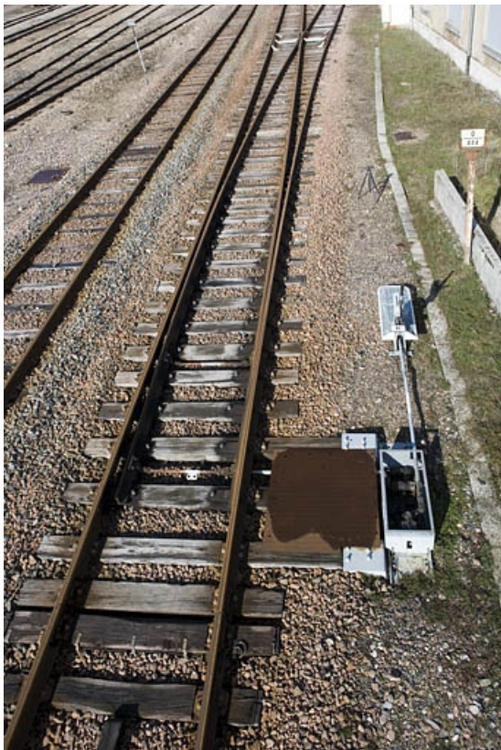
Vue d'ensemble plongeante, depuis le côté La Cluse. La pointe de coeur est visible en haut de l'image. 39, Champagnole, 13 avenue de la Gare
