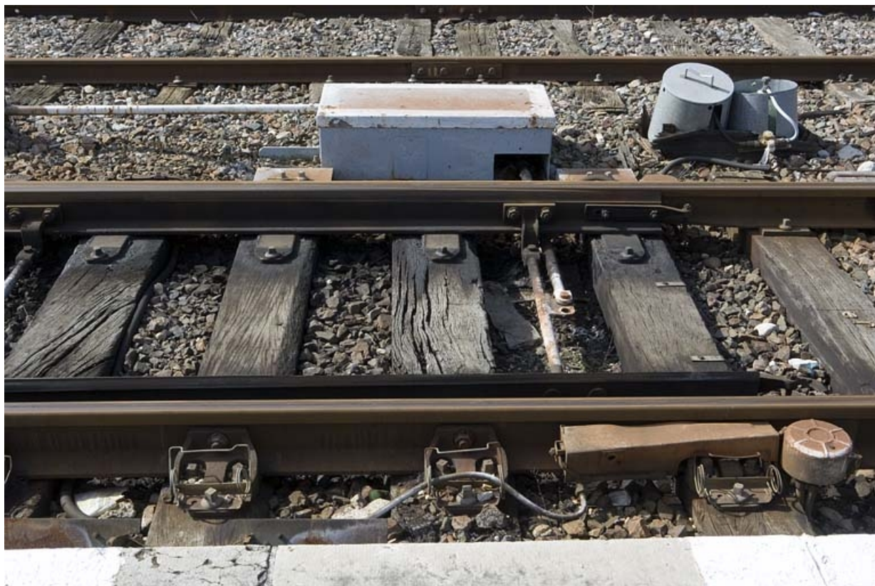
Exemple de rampe de réchauffage au gaz, sur un autre appareil (rampe partiellement démontée). Système de renvoi d'angle et bouteilles de gaz à l'arrière-plan.
