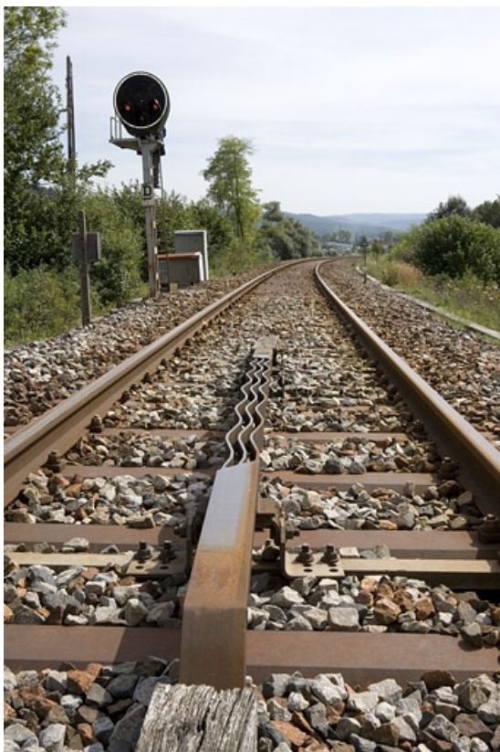
Vue d'ensemble, avec " crocodile ". Le crocodile, au premier plan, permet une répétition des signaux en cabine. 39, Champagnole, lieudit : aux Essards de Salins
