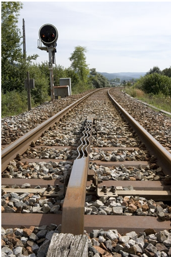
Vue d'ensemble, avec " crocodile ". Le crocodile, au premier plan, permet une répétition des signaux en cabine.
