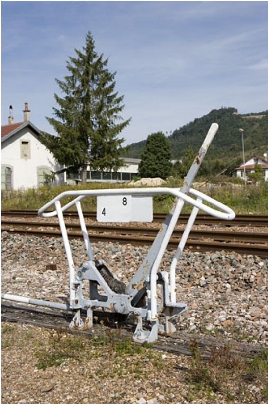
Levier de manoeuvre non enclenché. Levier d'appareil de voie des voies 4 et 8, à l'ouest, à l'extrémité de la gare côté La Cluse. 39, Champagnole, 13 avenue de la Gare
