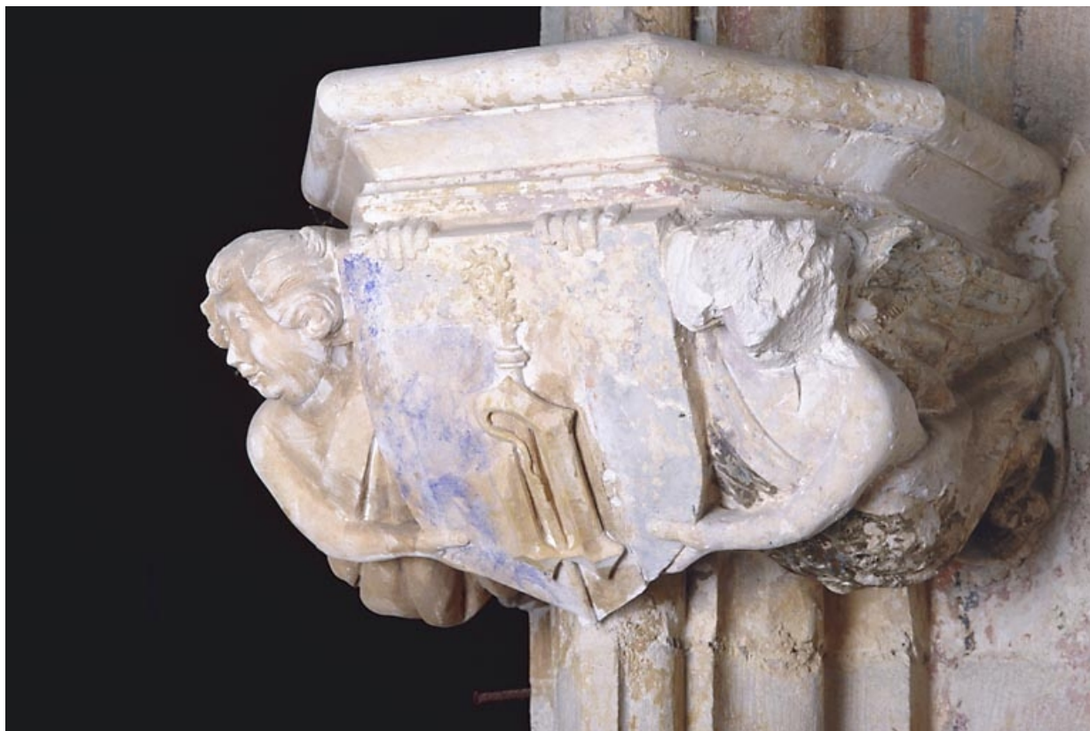
Console sud-ouest, vue de trois quarts. 39, Baume-les-Messieurs
