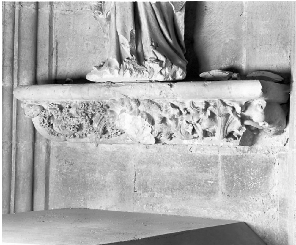
Grande console occidentale : vue d'ensemble.
