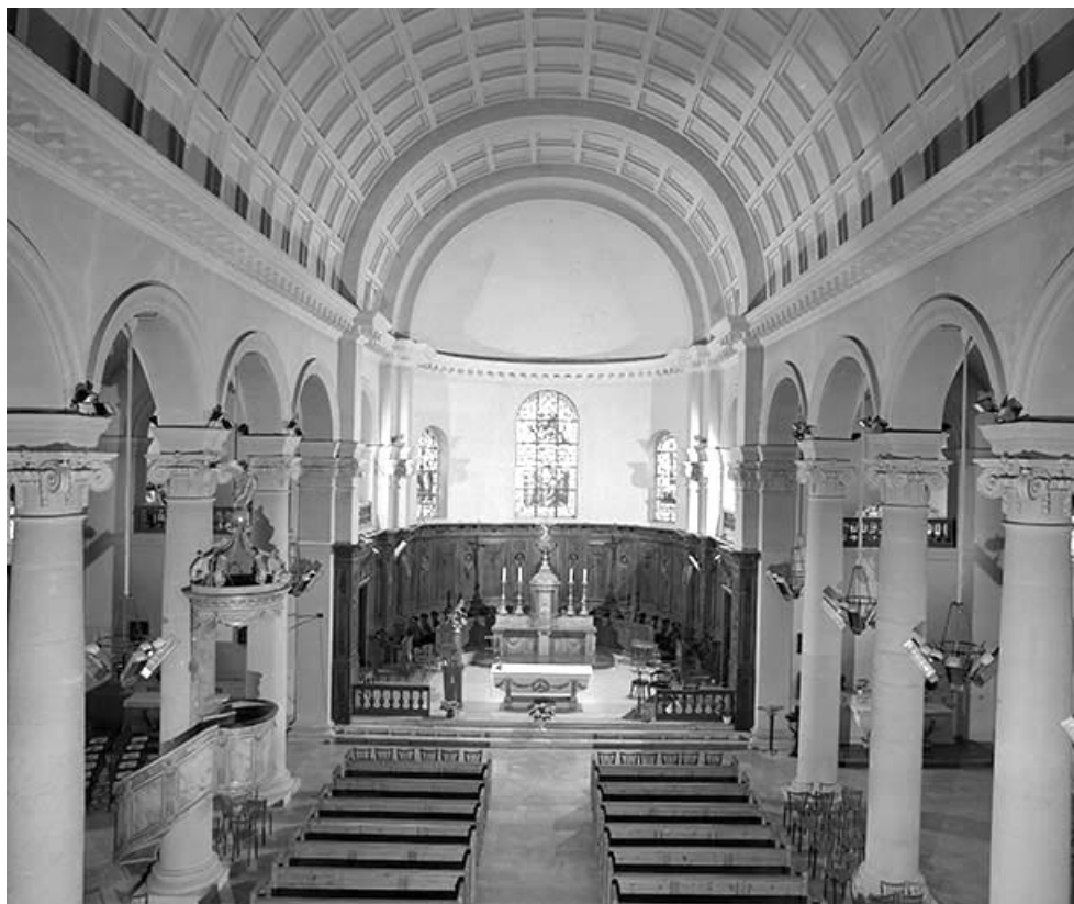
Le vaisseau central vu depuis la tribune (vue horizontale).
