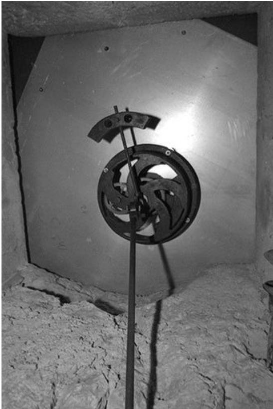
Mécánisme des aiguilles du cadran extérieur sud.
