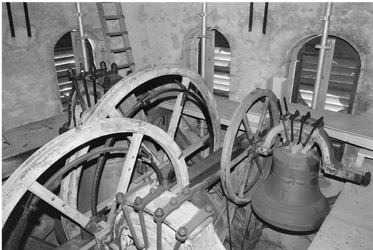
Vue d'ensemble du beffroi de charpente et de la 3e cloche.
