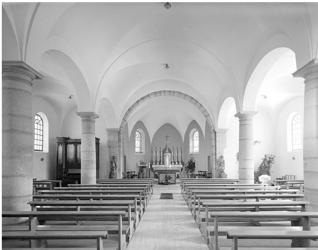
Le vaisseau central vu depuis l'entrée.
