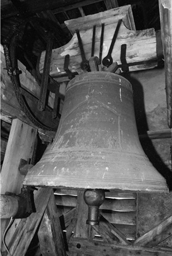
Vue d'ensemble, en contre-plongée.
