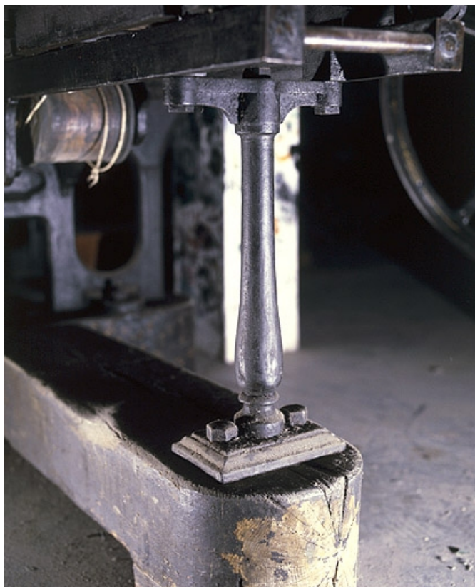
Détail du pied soutenant les rails du chariot.
