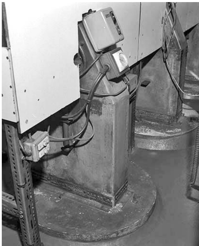
Support en béton d'une place.
