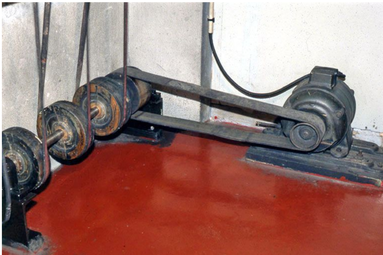
Moteur électrique Roulland et arbre de transmission.
