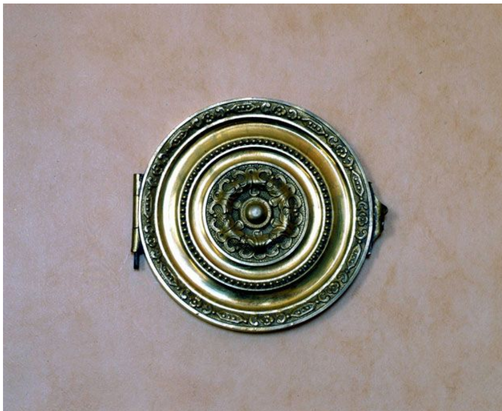
Bouche de chaleur de la cheminée, fermée.
