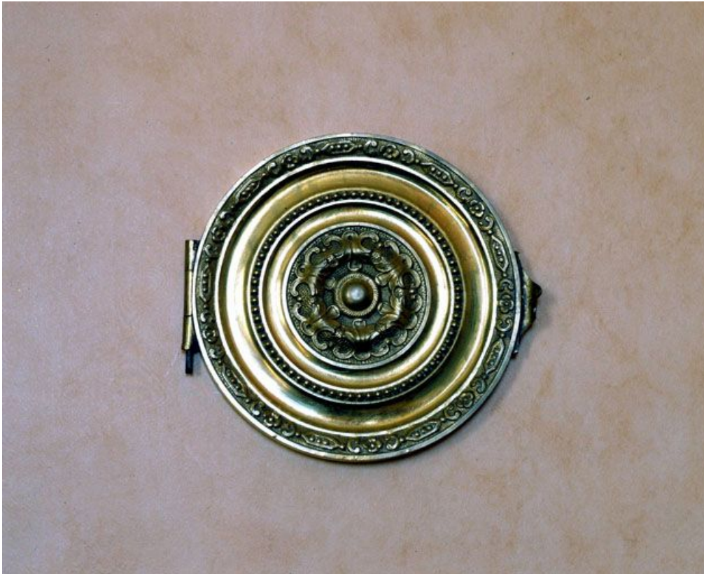
Bouche de chaleur de la cheminée, fermée.
