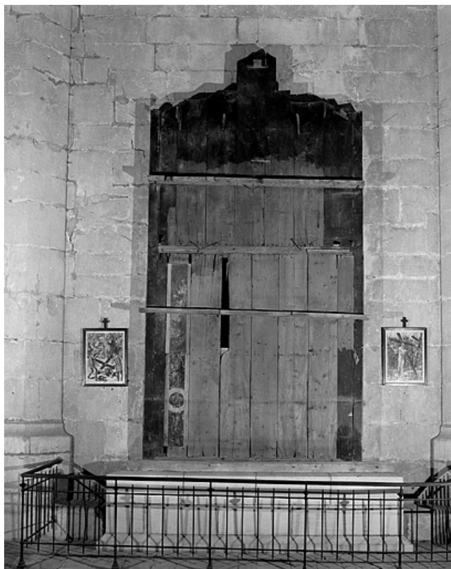
Vue du bâti du retable, pendant sa restauration en 1999.
