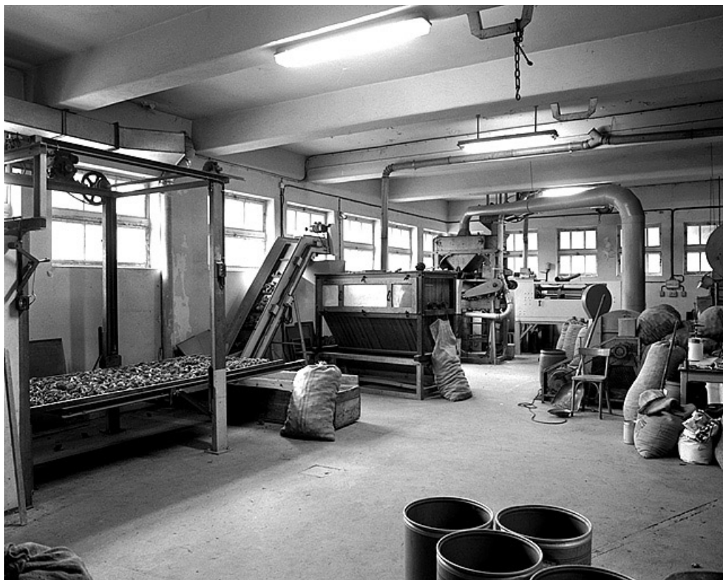
Intérieur de l'atelier de la Sécherie de graines de résineux.
