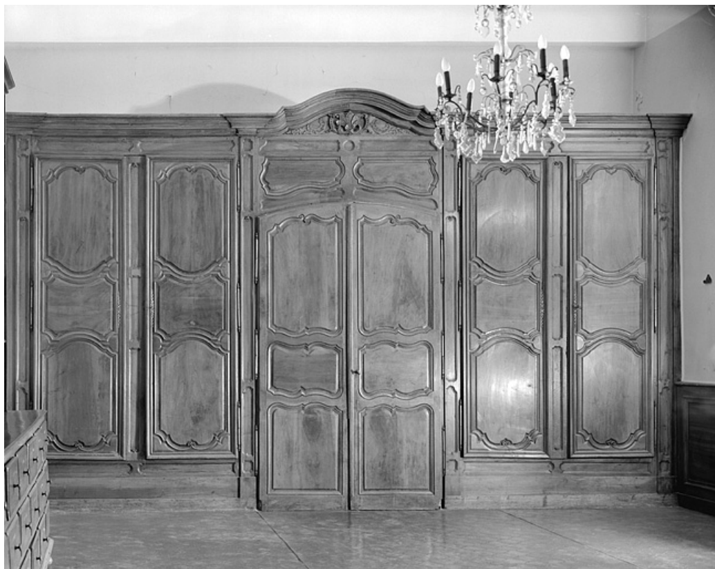
Placards et vantaux de la porte d'entrée. 39, Lons-le-Saunier place de l' Hôtel de Ville
