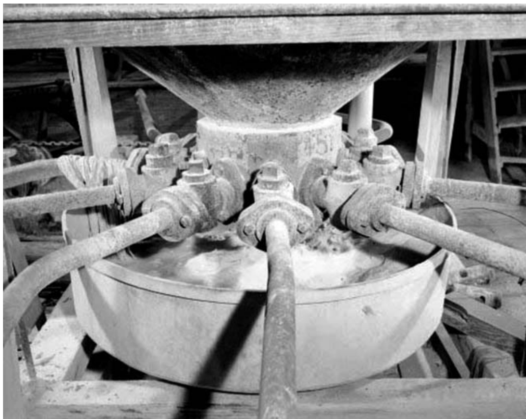
Système de distribution du mélange eau-sable : départ des conduites.
