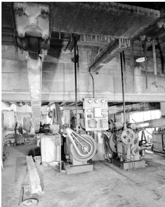
Systèmes de descente des châssis porte-lames. Bielle au premier plan.
