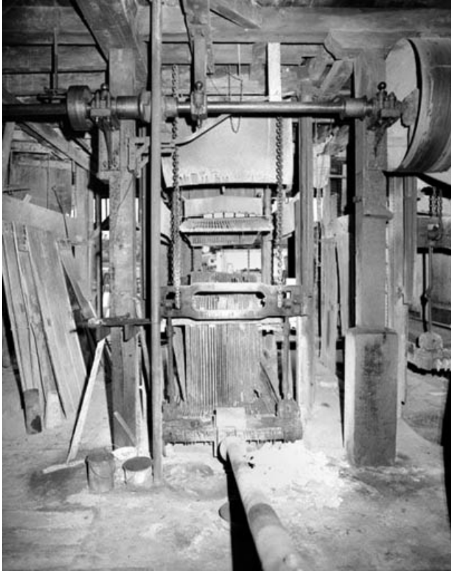
Système d'entraînement : côté châssis porte-lames. Transmission au plafond, extrémité de la bielle visible au centre. 39, Saint-Amour, 2 à 6 rue de la Marbrerie
