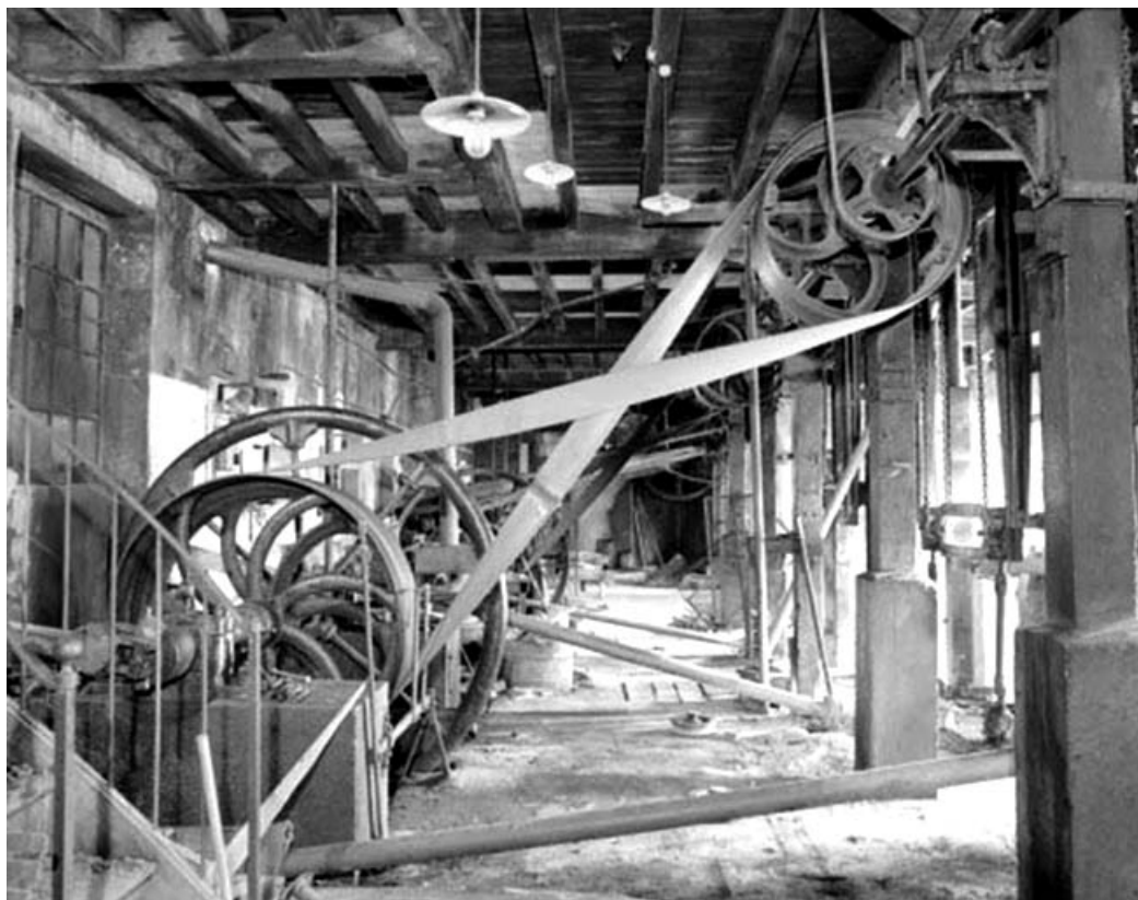
Système d'entraînement : côté transmission. Manivelle et volant d'inertie à droite, bielle au centre. 39, Saint-Amour, 2 à 6 rue de la Marbrerie
