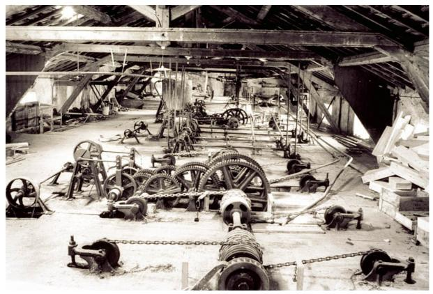
Système de descente des châssis porte-lames.
