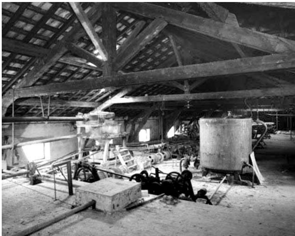
Cuve, système de distribution de la noria et systèmes de descente des châssis multilames dans le comble. 39, Saint-Amour, 2 à 6 rue de la Marbrerie
