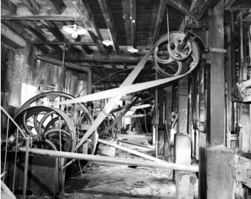
Transmission des châssis multilames.
