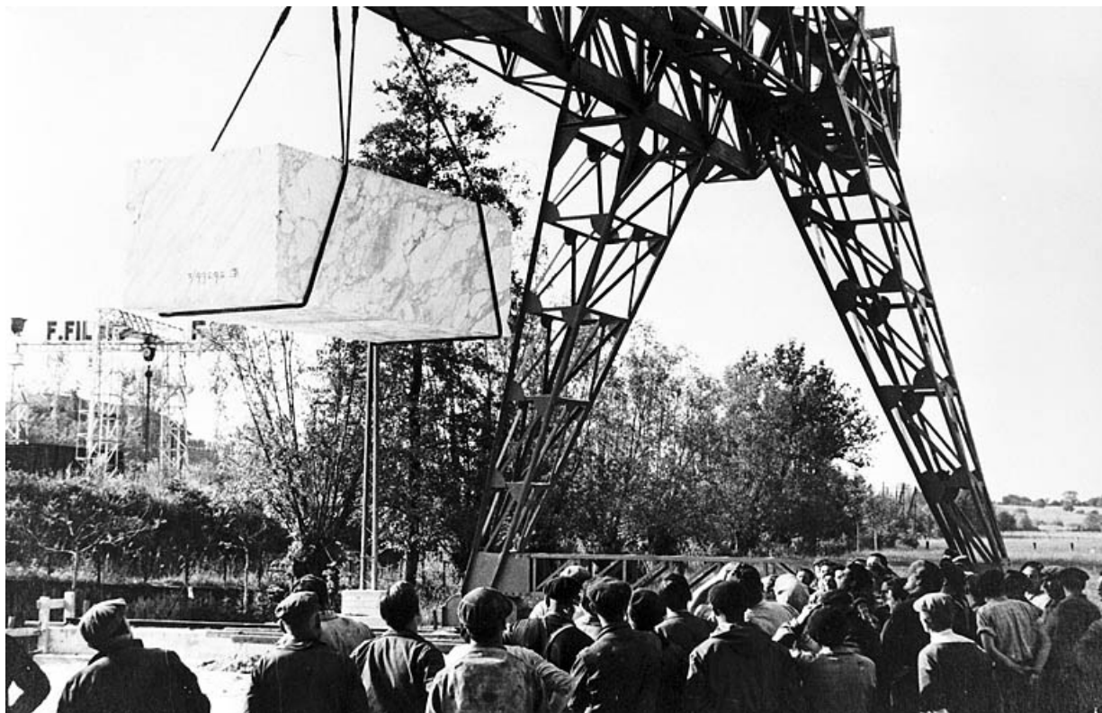
Inauguration : essai de résistance avec un bloc de marbre de 30 tonnes.
