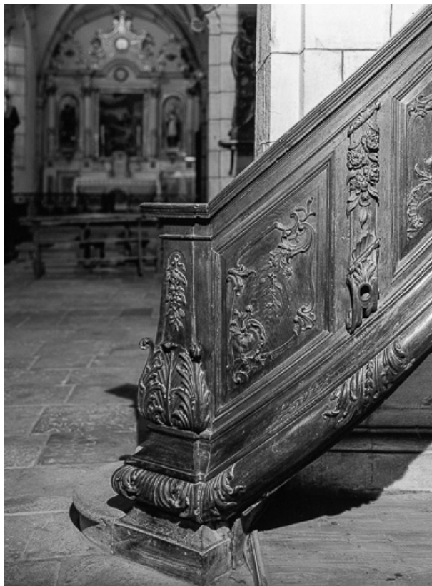
Départ de la rampe. 39, Conliège Eglise
