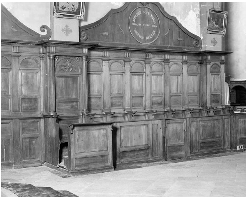
Lambris et stalles du mur sud du choeur. 39, Villevieux
