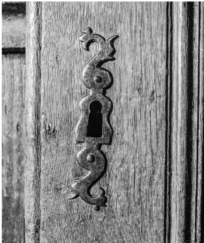
Détail : entrée de serrure.
